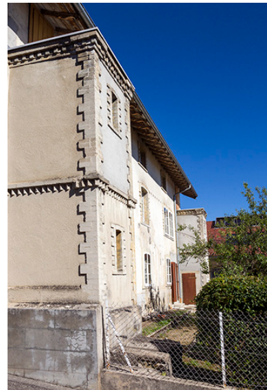
Façade antérieure, vue en enfilade. Phot. Yves Sancey IVR43_20132502062NUC2A
