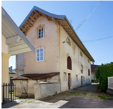
Façades postérieure et latérale droite.
