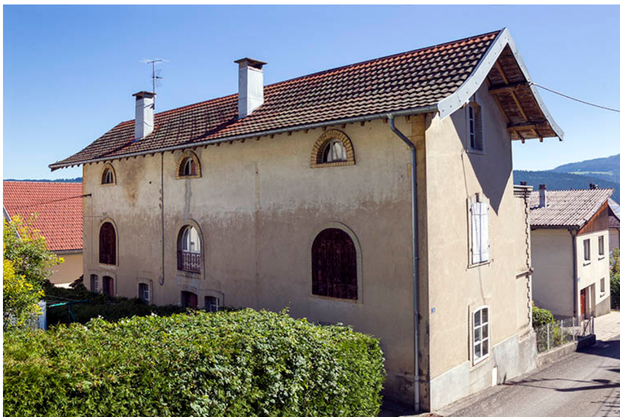
Façades postérieure et latérale gauche.
