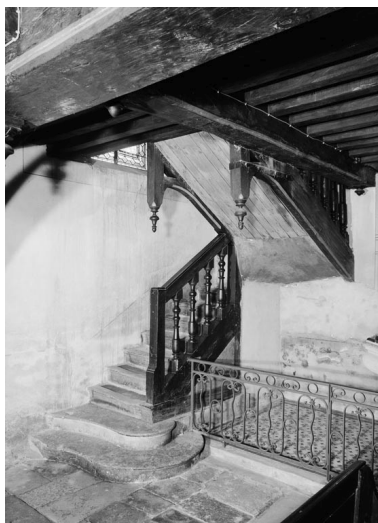
Escalier. Phot. Michel Rosso IVR26_19792101020V
