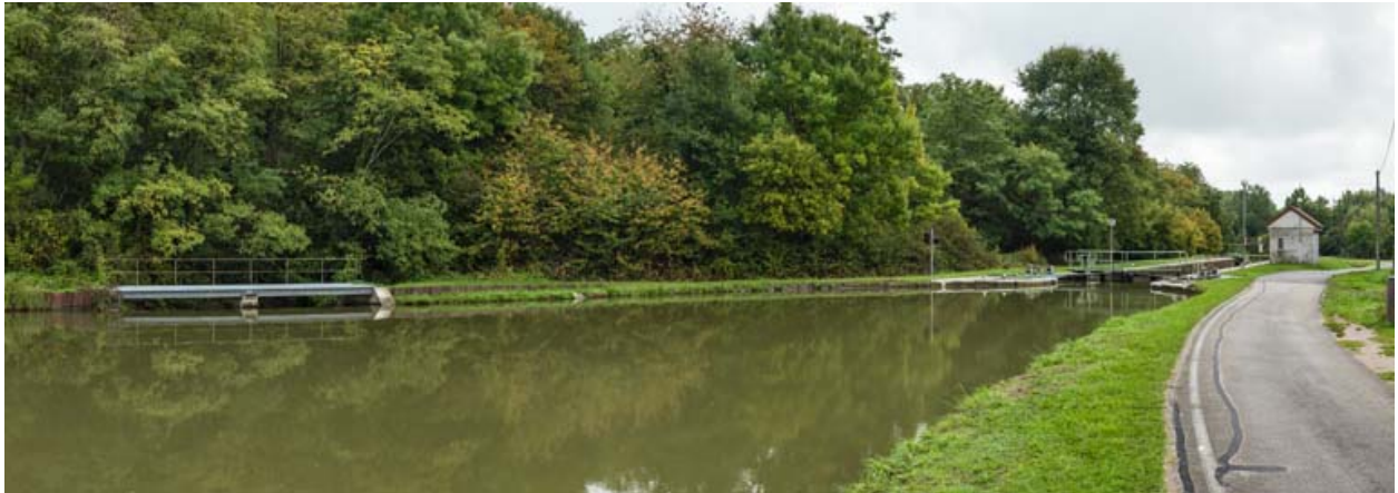
Vue d'ensemble du site d'écluse.
