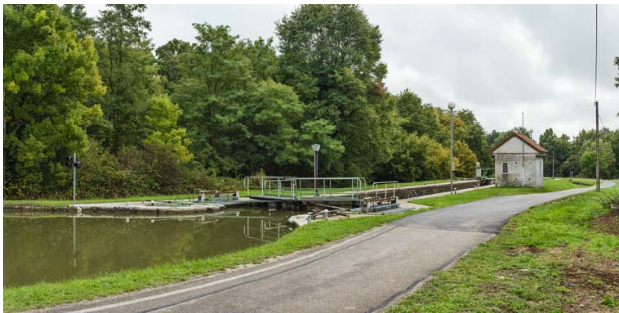
Vue d'ensemble du site d'écluse.
