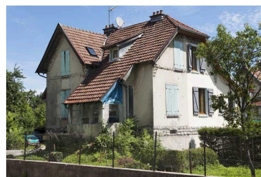
Maison vue de trois quarts arrière. Phot. Jérôme Mongreville IVR43_20112502173NUC4A
