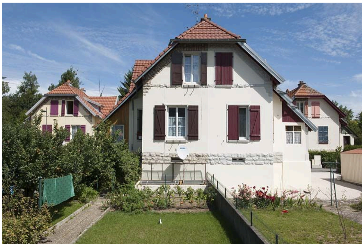
Pignons de maisons vus de face.
