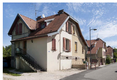
Alignement de façades. Phot. Jérôme Mongreville IVR43_20112502170NUC4A
