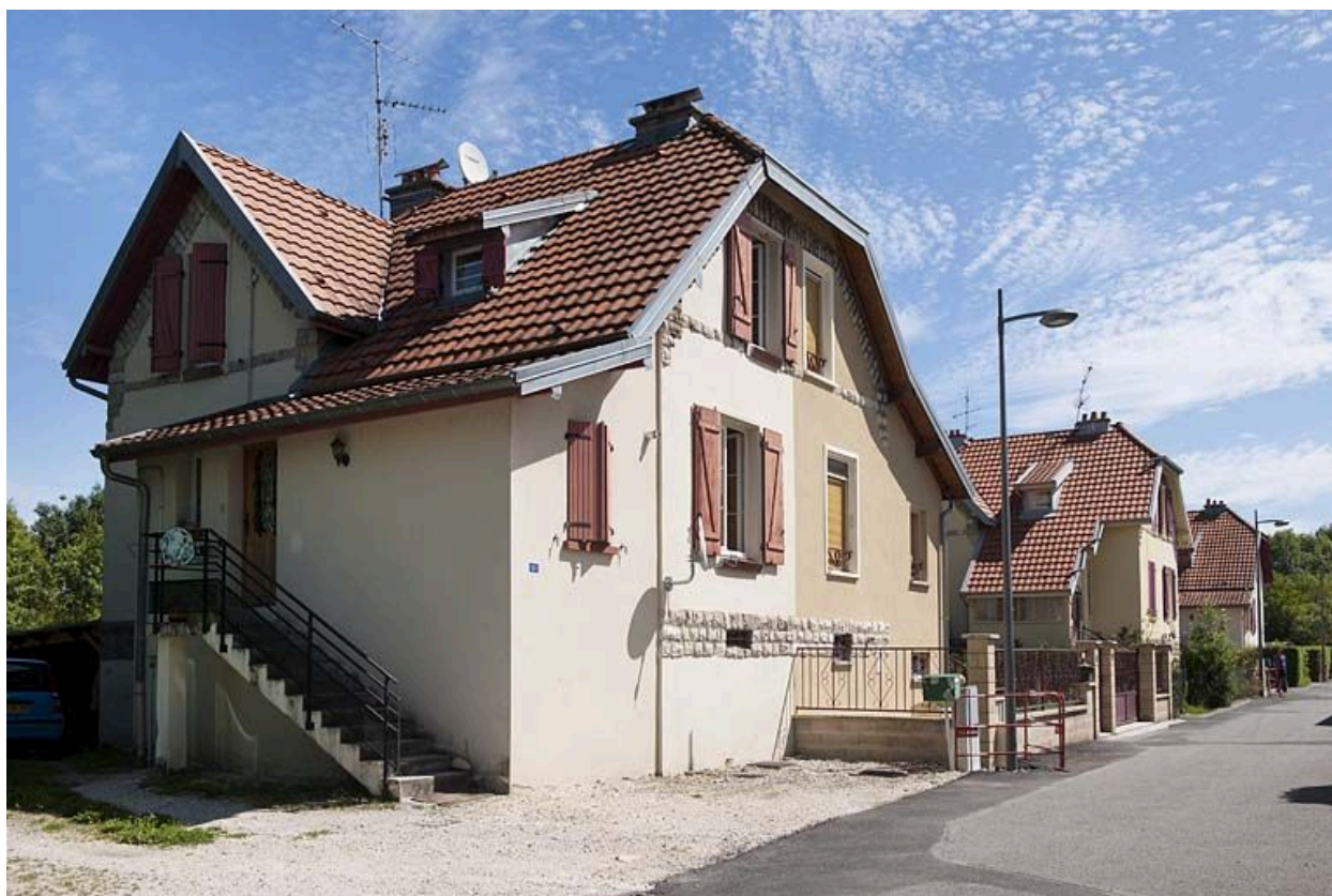
Alignement de façades.
