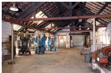
Travée nord-est de l'atelier dit des Balanciers. Phot. Jérôme Mongreville IVR43_20057000100NUCA
