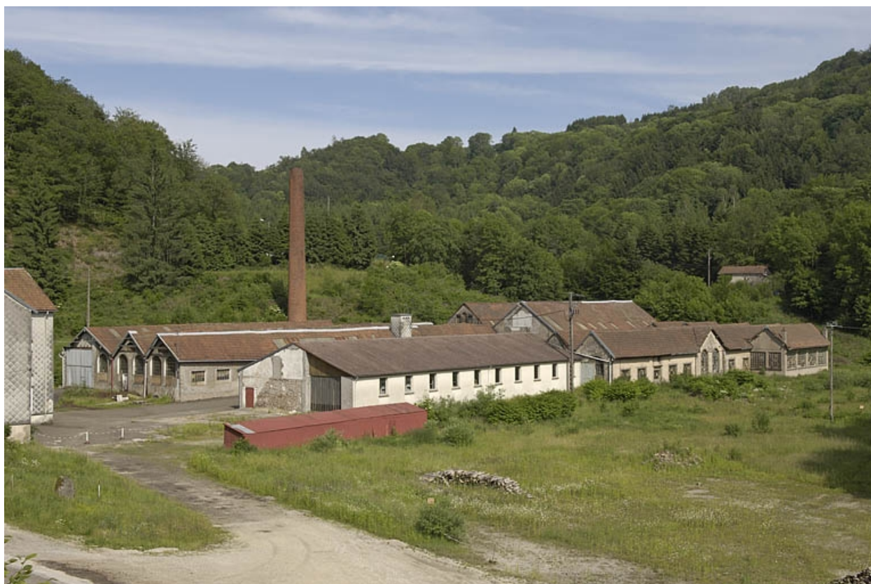
Les bâtiments de production vus depuis l'ouest.
