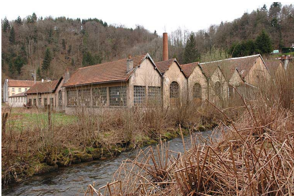
Vue des ateliers depuis le sud.
