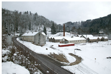
Vue d'ensemble, depuis l'ouest, sous la neige. Phot. Jérôme Mongreville IVR43_20057000121NUCA
