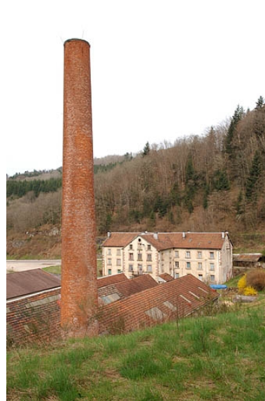
Vue plongeante depuis le nord-est (cadrage vertical). Phot. Jérôme Mongreville IVR43_20057000176NUCA
