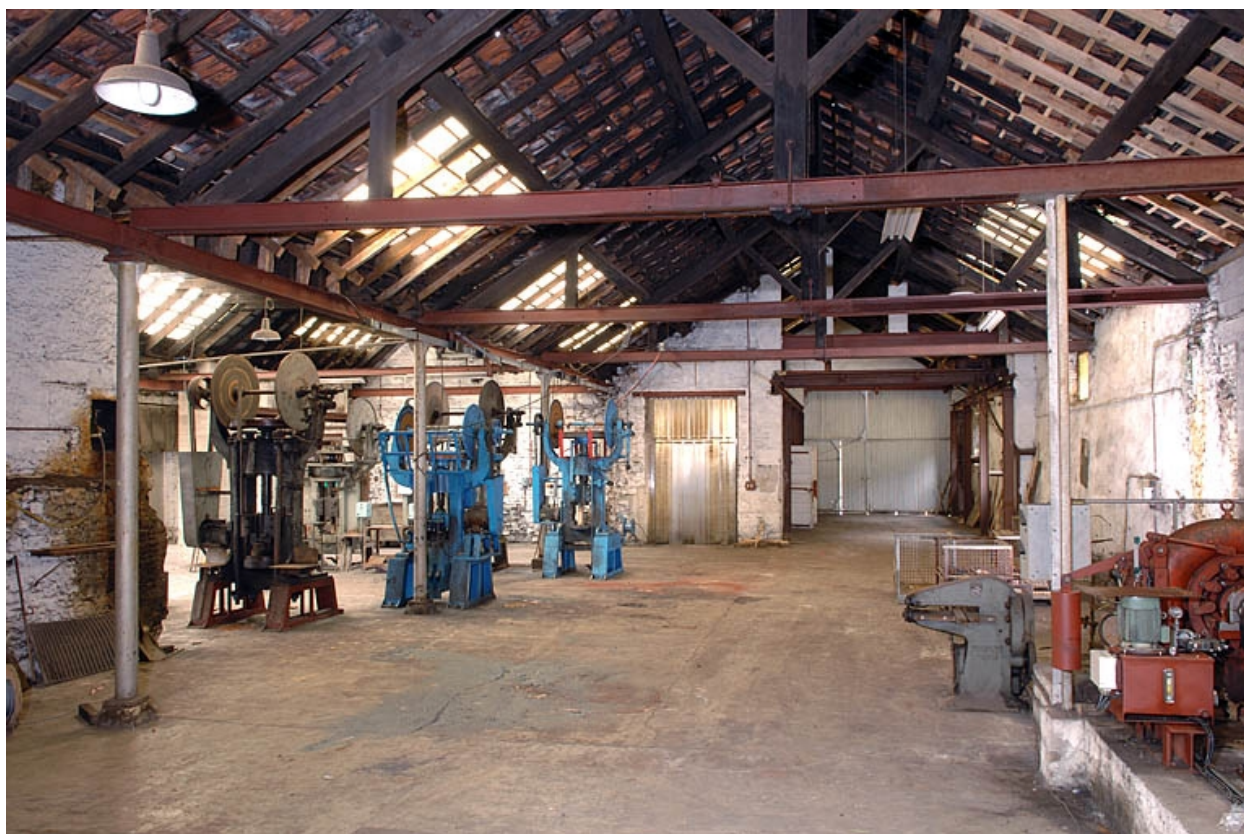
Travée nord-est de l'atelier dit des Balanciers.
