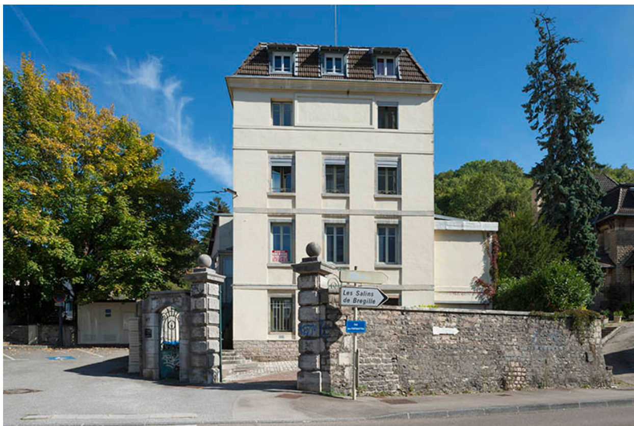
Façade ouest de l'atelier de fabrication.
