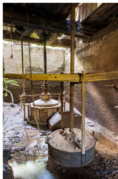
La chambre d'eau des turbines. Phot. Jérôme Mongreville IVR43_20152501250NUC4A
