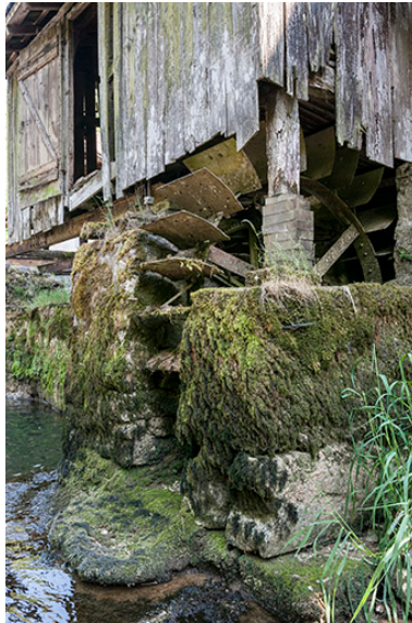
Bâtiment d'eau. Roue en dessous. Phot. Jérôme Mongreville IVR43_20152501257NUC4A
