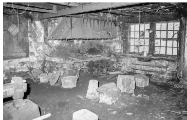
La forge en 1980. Phot. Bernard Lardière IVR43_19802500381Z
