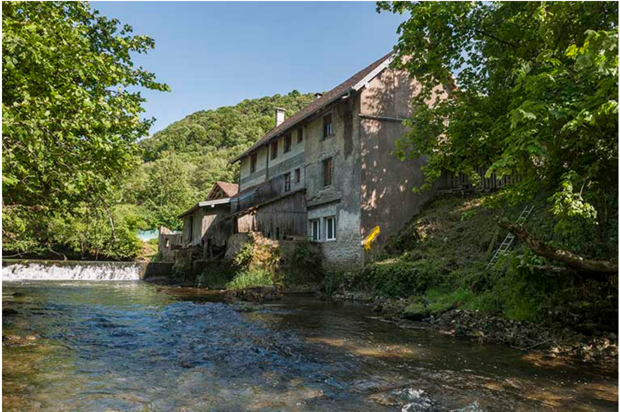
Vue d'ensemble depuis l'aval.
