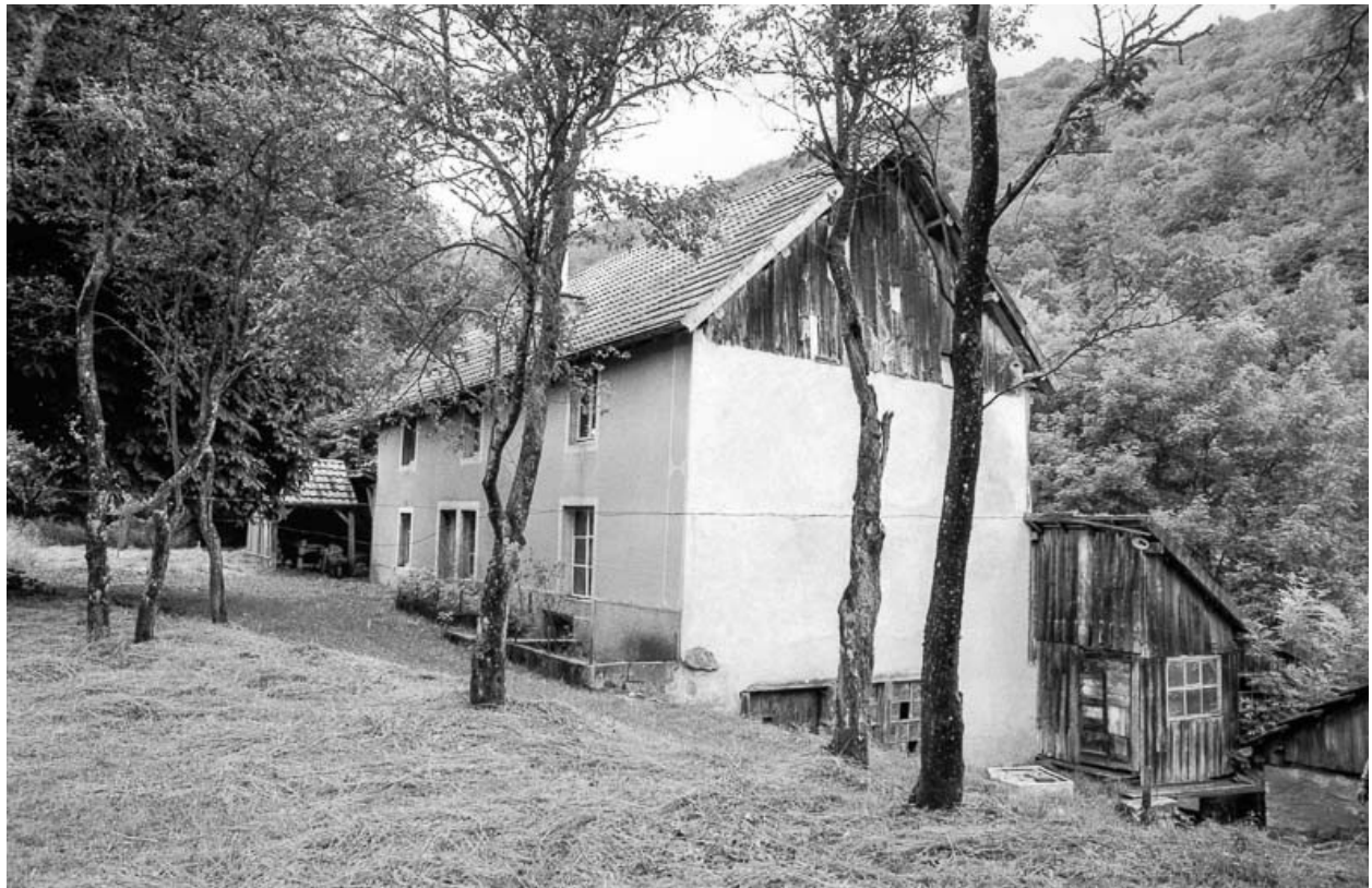
Vue d'ensemble depuis le sud-est en 1980.
