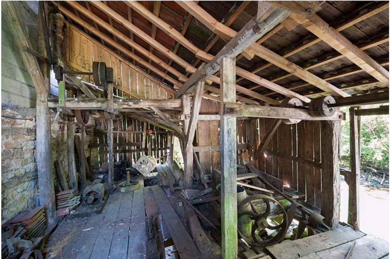
Vue intérieure du bâtiment d'eau.
