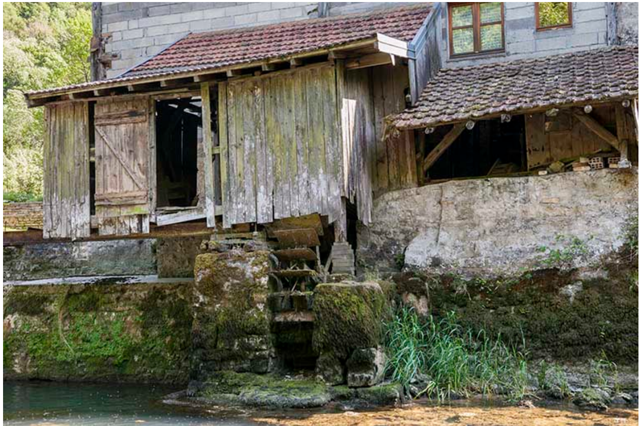
Façade nord. Le bâtiment d'eau.
