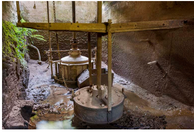
Les turbines. Phot. Jérôme Mongreville IVR43_20152501249NUC4A
