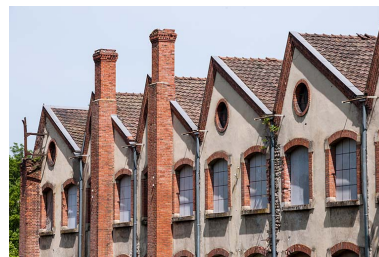
Détail des pignons de l'atelier de fabrication. Phot. Jérôme Mongreville IVR43_20142501331NUC4A
