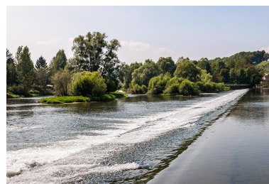
Barrage sur le Doubs. Phot. Jérôme Mongreville IVR43_20142501389NUC4A
