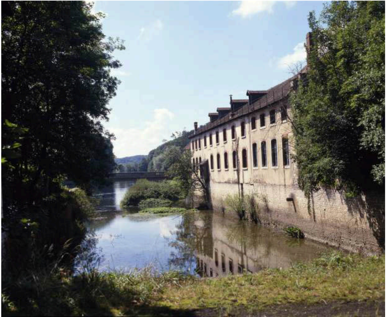
Façade est du bâtiment industriel en 1986 (cliché inversé).
