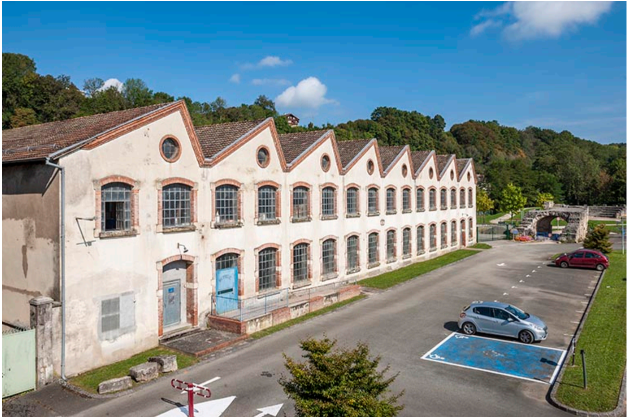
Atelier de fabrication ouest vu de trois quarts.
