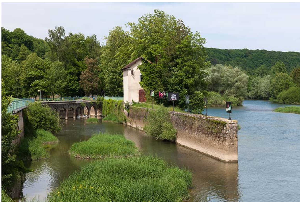
L'ancien canal de fuite et le transformateur.
