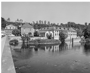
Vue d'ensemble depuis le pont en 1976. Phot. Bernard Lardière IVR43_19762500079X
