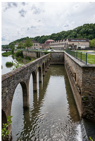
Ancien canal de fuite et atelier au second plan. Phot. Jérôme Mongreville IVR43_20142501335NUC4A
