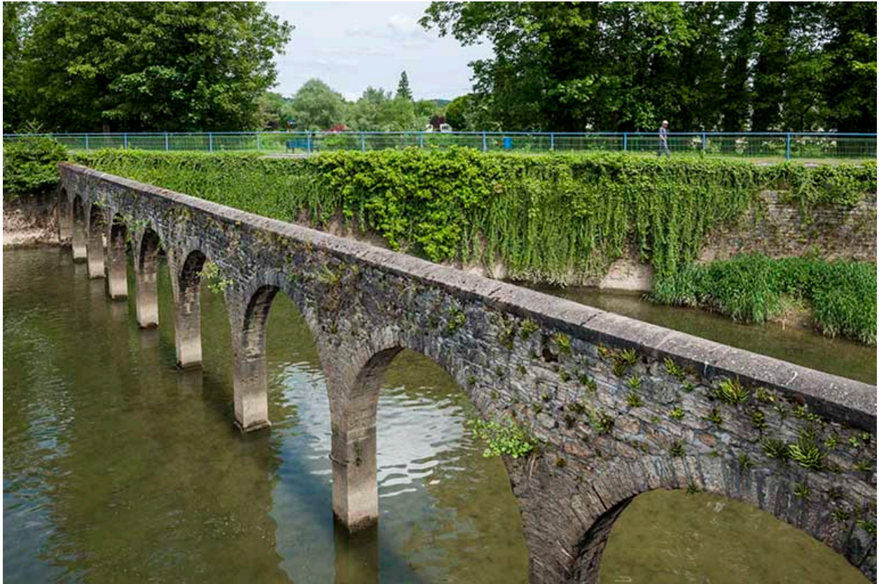
Arcades enjambant l'ancien canal de fuite.
