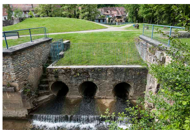
Vestiges des évacuations des turbines hydrauliques. Phot. Jérôme Mongreville IVR43_20142501336NUC4A
