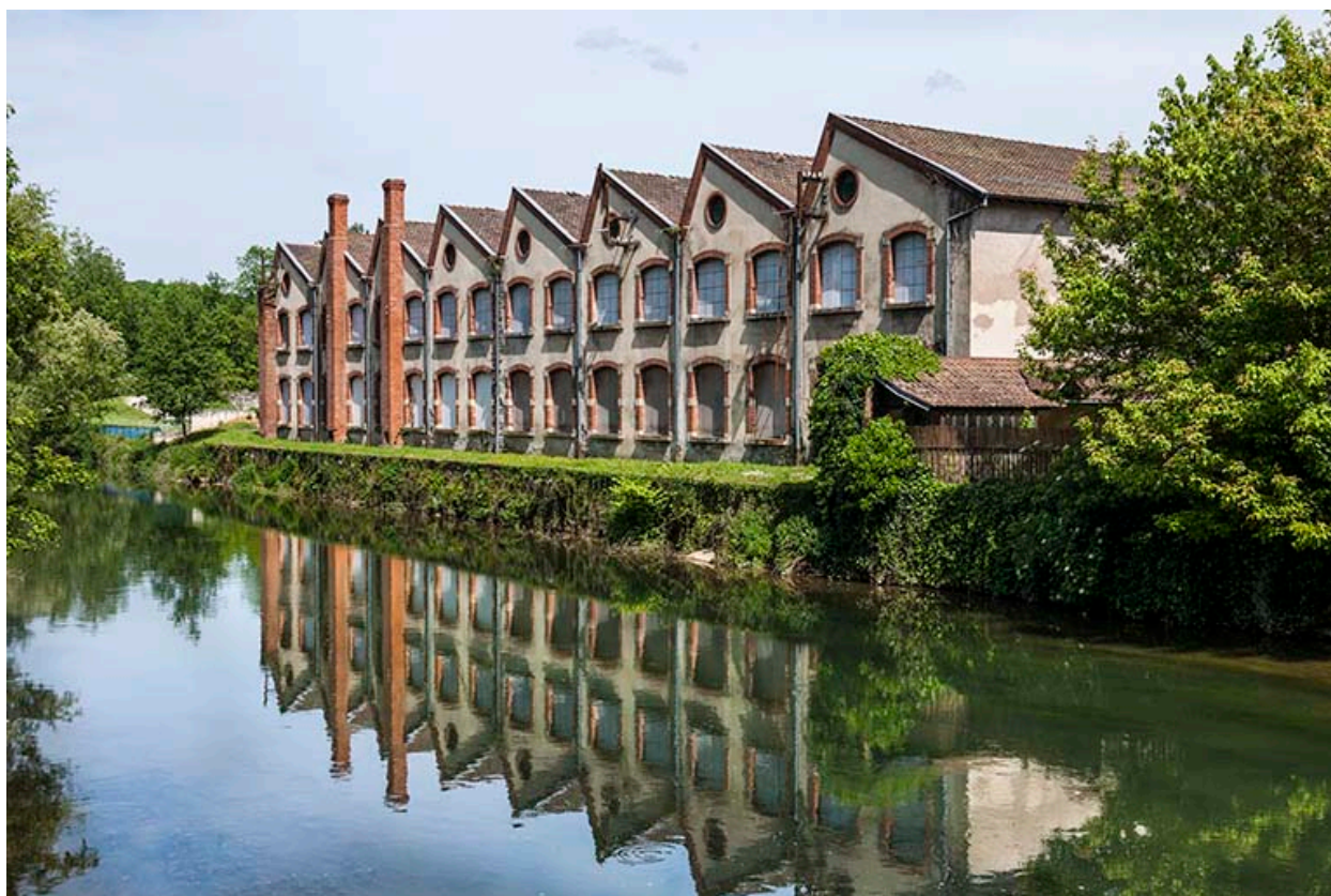
Façade ouest de l'atelier de fabrication.
