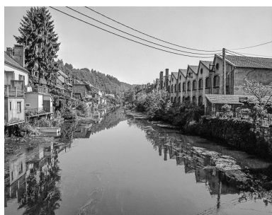
Vue de l'usine sur le petit bras du Doubs en 1976. Phot. Bernard Lardière IVR43_19762500081X
