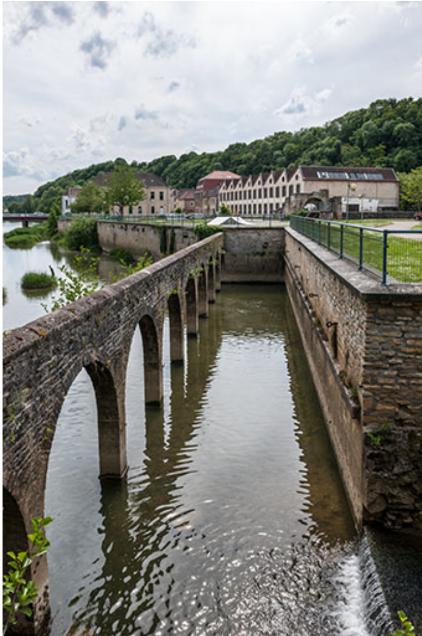
Ancien canal de fuite et atelier au second plan.
