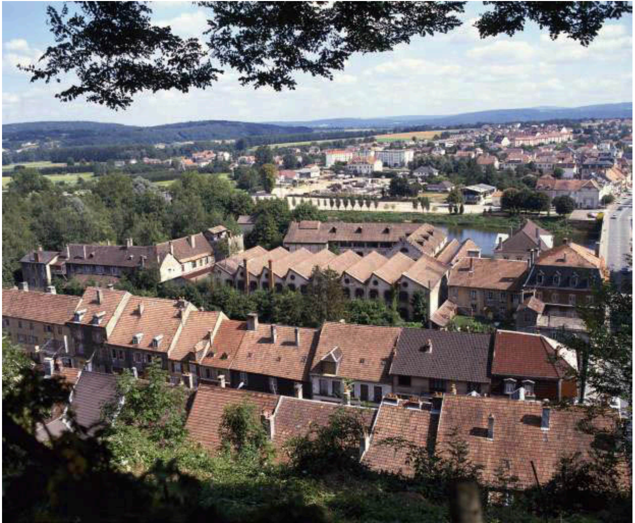
Vue d'ensemble depuis l'ouest en 1986.
