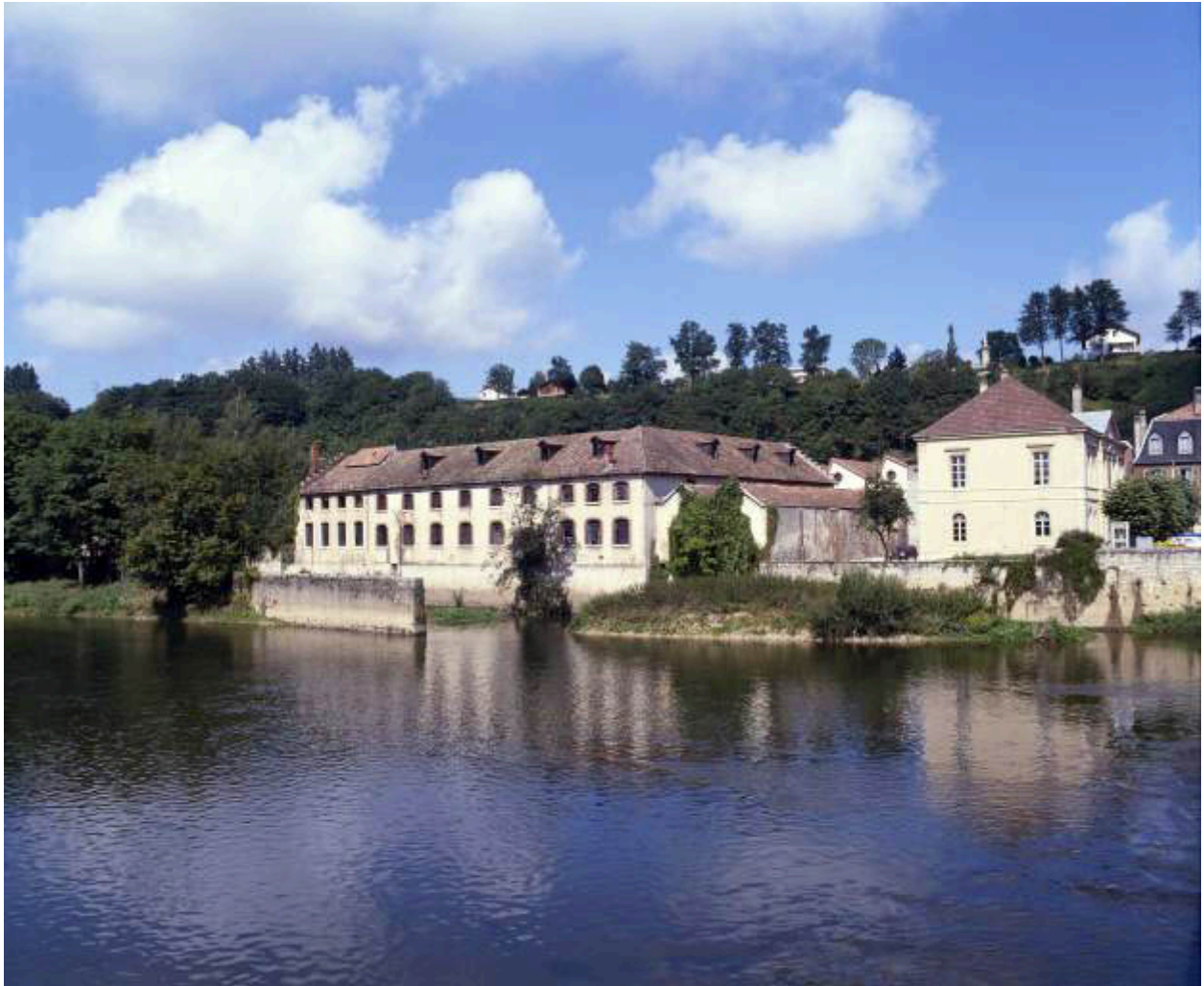
Vue d'ensemble depuis le pont en 1986 (cliché inversé).
