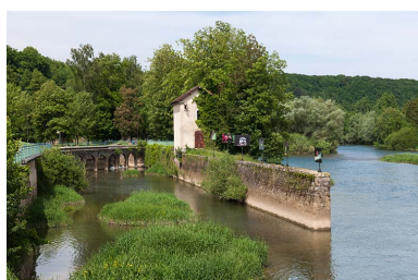
L'ancien canal de fuite et le transformateur.
