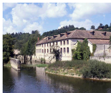
Bâtiment industriel en 1986 (cliché inversé). Phot. Yves Sancey IVR43_19862500545XA
