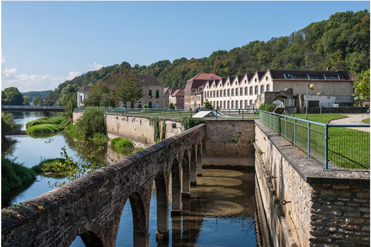
Vue d'ensemble depuis le nord du site.
