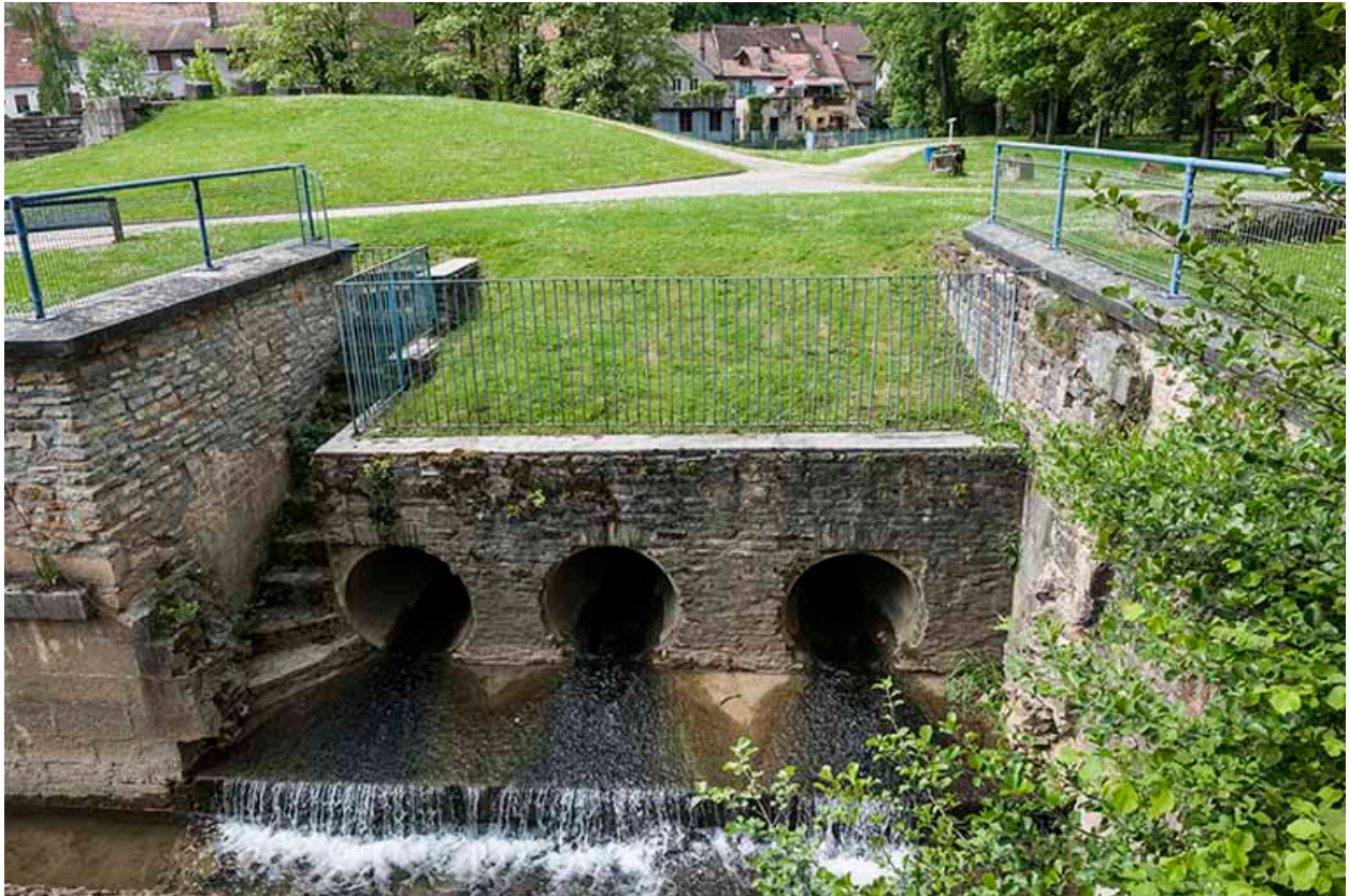
Vestiges des évacuations des turbines hydrauliques.
