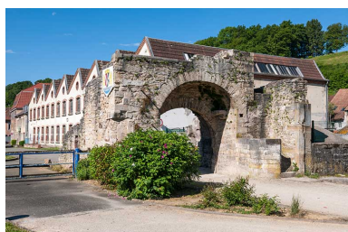
Atelier de fabrication et vestiges de la porte du château. Phot. Jérôme Mongreville IVR43_20142501329NUC4A
