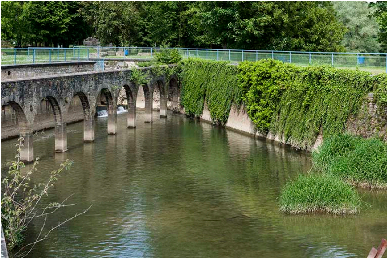
L'ancien canal de fuite.
