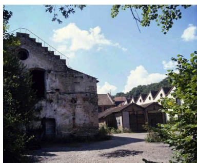
Vue depuis la cour de l'usine en 1986. Phot. Yves Sancey IVR43_19862500549XA
