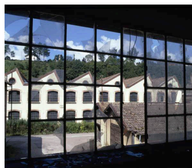
Atelier de 1911 vu à travers le vitrage d'un bâtiment à l'est en 1986. Phot. Yves Sancey IVR43_19862500551XA
