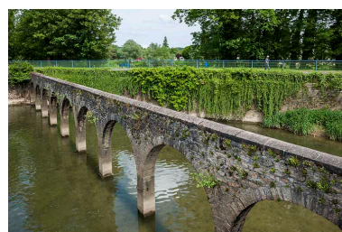
Arcades enjambant l'ancien canal de fuite.
