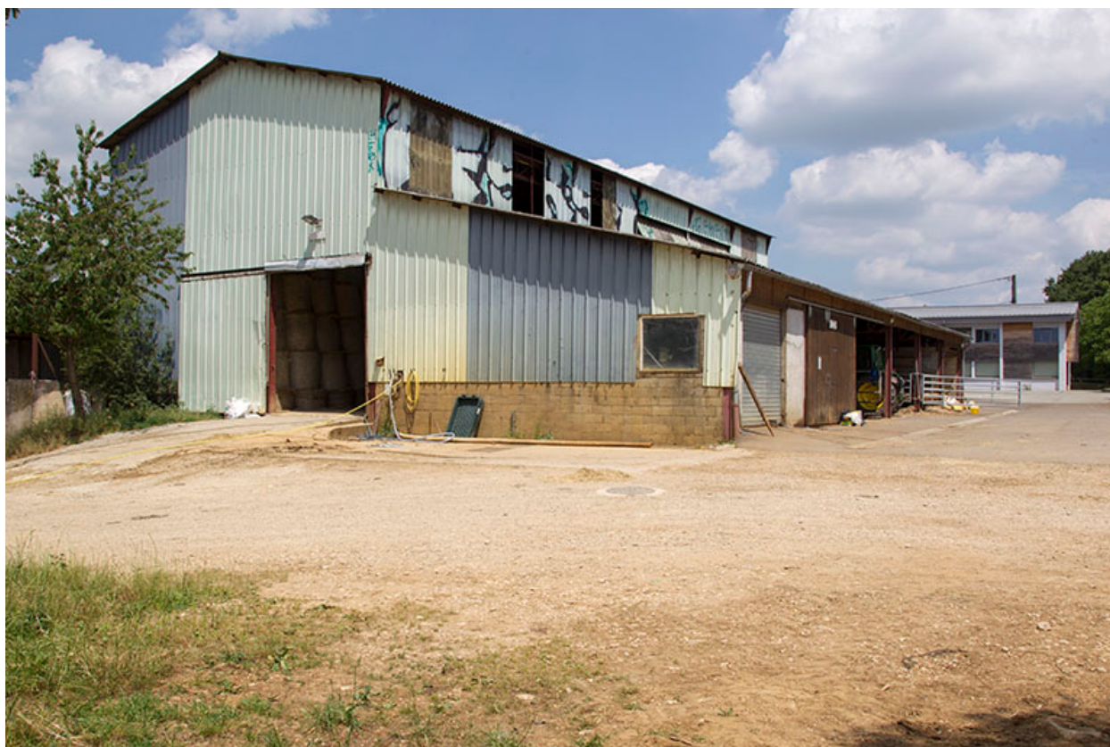
Vue de trois-quart sud-est de l'entrepôt agricole.
