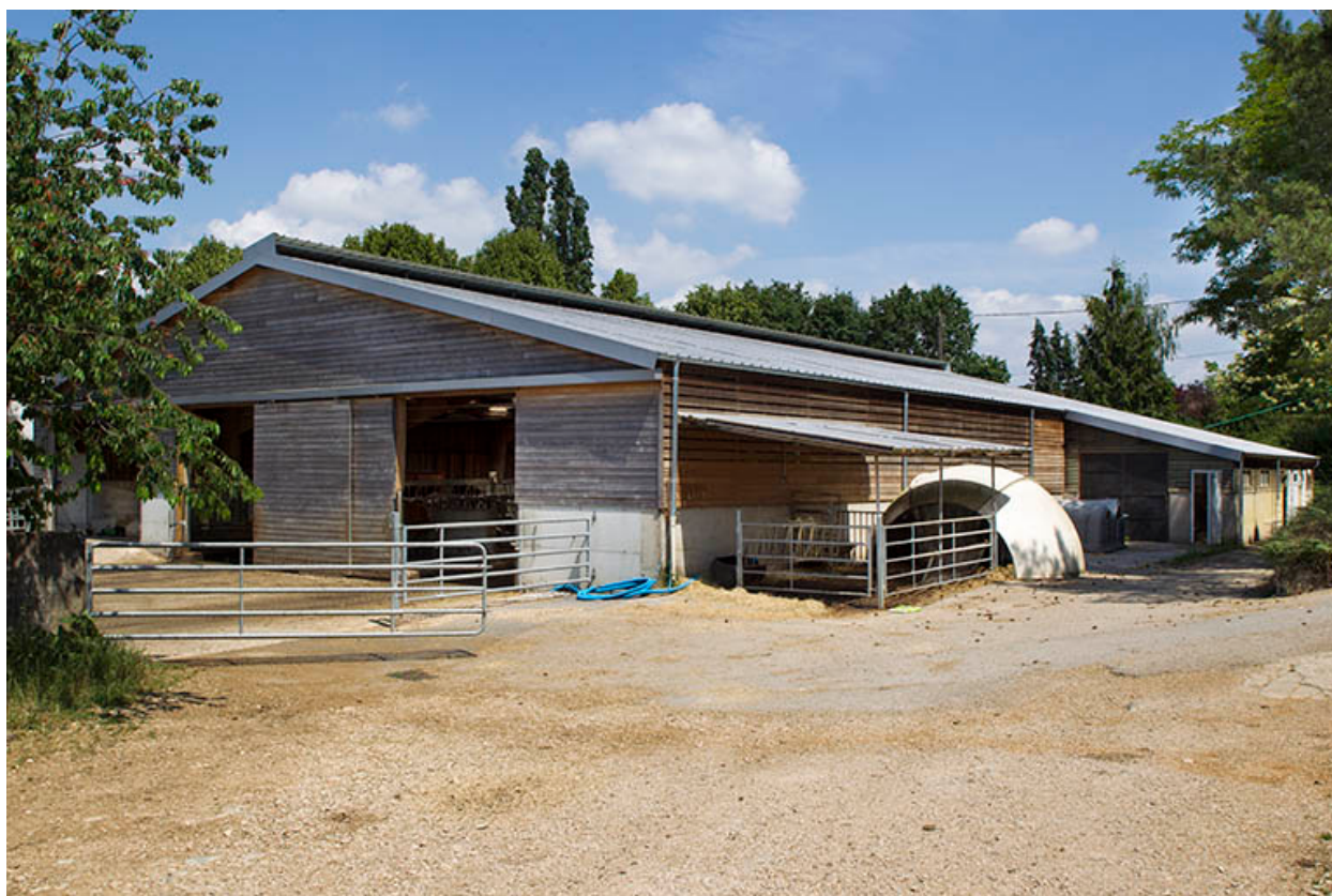
L'étable ouest vue de trois-quart sud-est.
