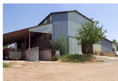
Pignon sud de l'entrepôt agricole. Phot. Sonia Dourlot IVR43_20142500993NUC2A
