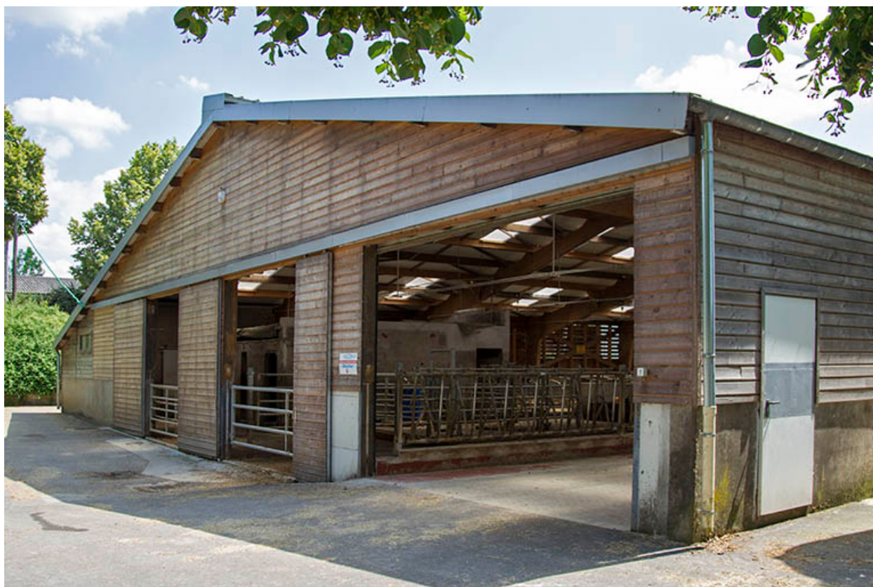
Pignon nord de l'étable ouest.
