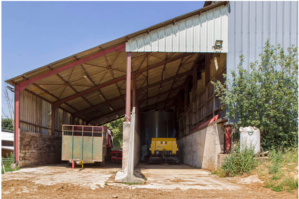
Appenti à l'ouest de l'entrepôt agricole.
