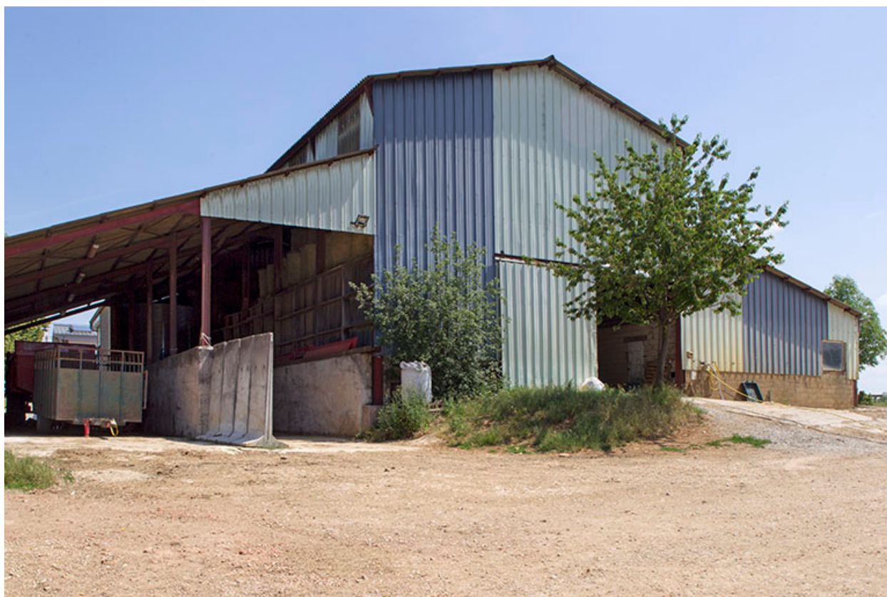
Pignon sud de l'entrepôt agricole.
