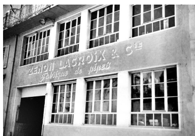
Façade antérieure du n° 8 bis. Phot. Jérôme Mongreville IVR43_19923900115X
