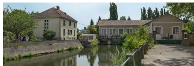
Le moulin et le bief de dérivation. A gauche, l'arrière de la maison éclusière.
