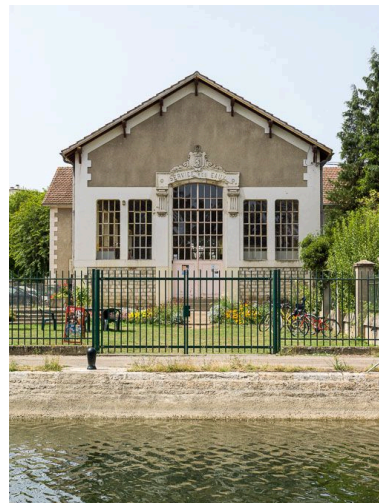
Le bâtiment du moulin : de face. Phot. Pierre-Marie Barbe-Richaud IVR26_20138900162NUC4A
