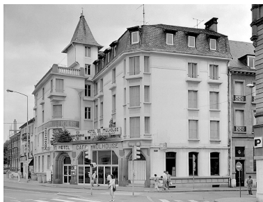
Vue d'ensemble côté rue Cuvier. Le pavillon dominant l'ensemble contient la cage d'ascenseur. Phot. Jérôme Mongreville IVR43_19872500274V
