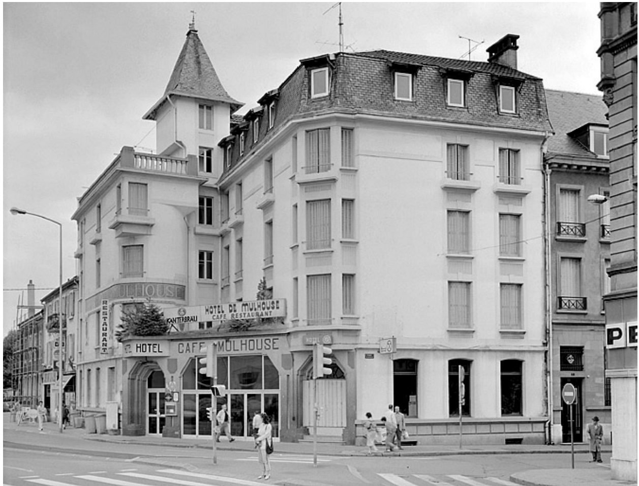
Vue d'ensemble côté rue Cuvier. Le pavillon dominant l'ensemble contient la cage d'ascenseur.
