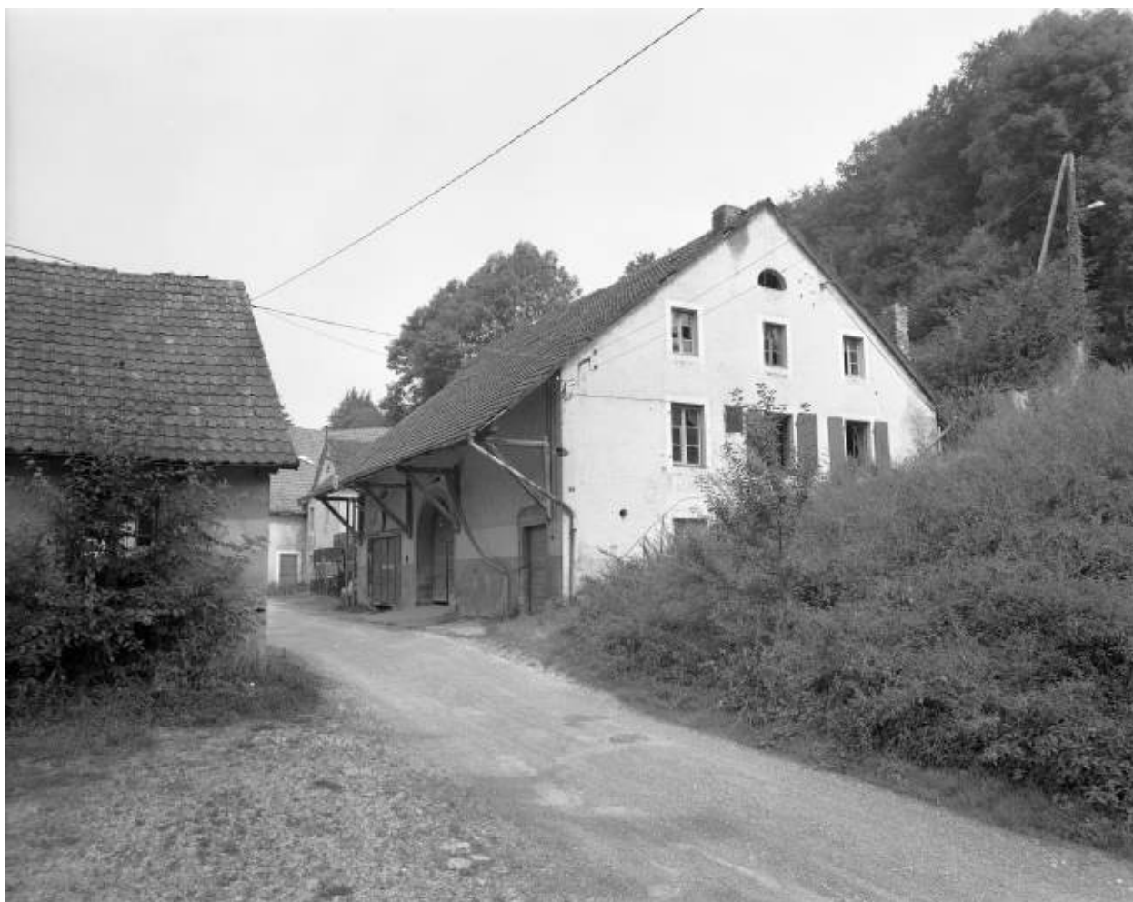
Bâtiment agricole en 1981.
