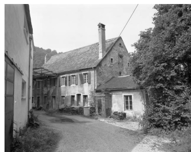
Maison de direction en 1981. Phot. Yves Sancey IVR43_19812500480X
