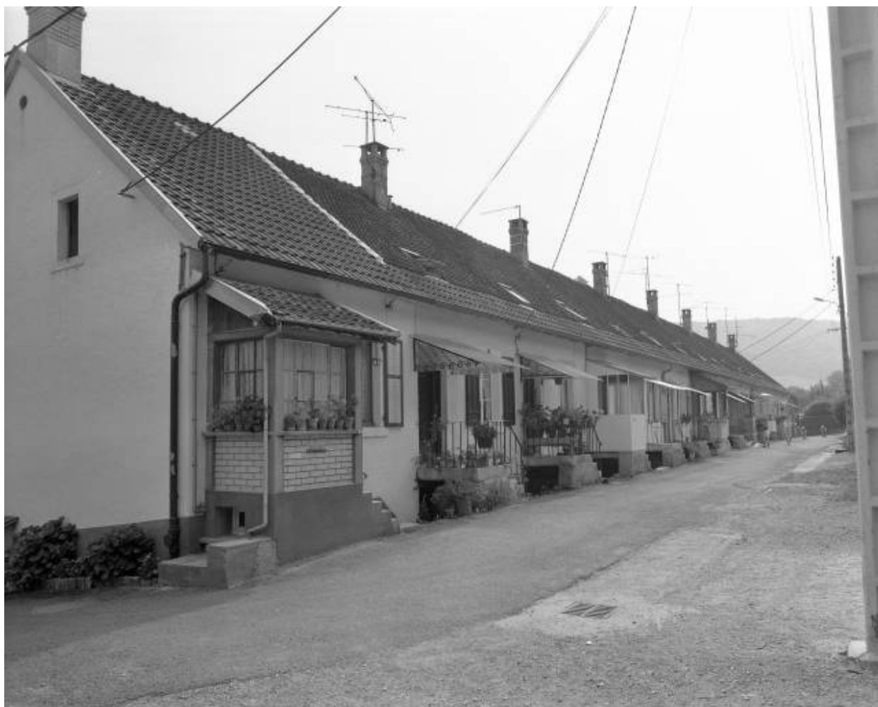
Logement ouvrier. Façade postérieure en 1981.
