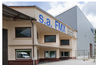
Façade nord : le nouvel atelier des presses.
