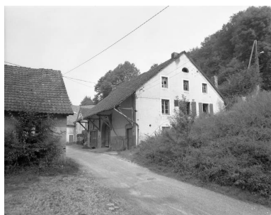
Bâtiment agricole en 1981. Phot. Yves Sancey IVR43_19812500477X
