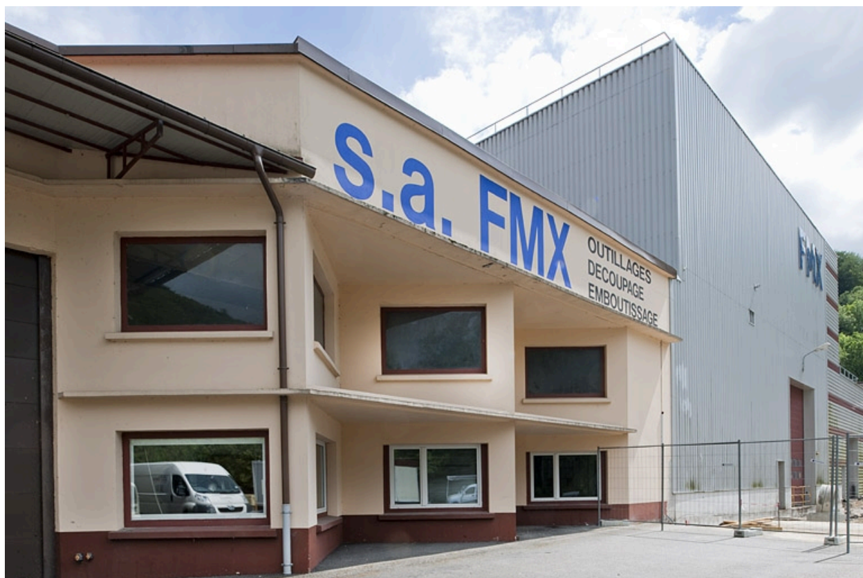
Façade nord : le nouvel atelier des presses.
