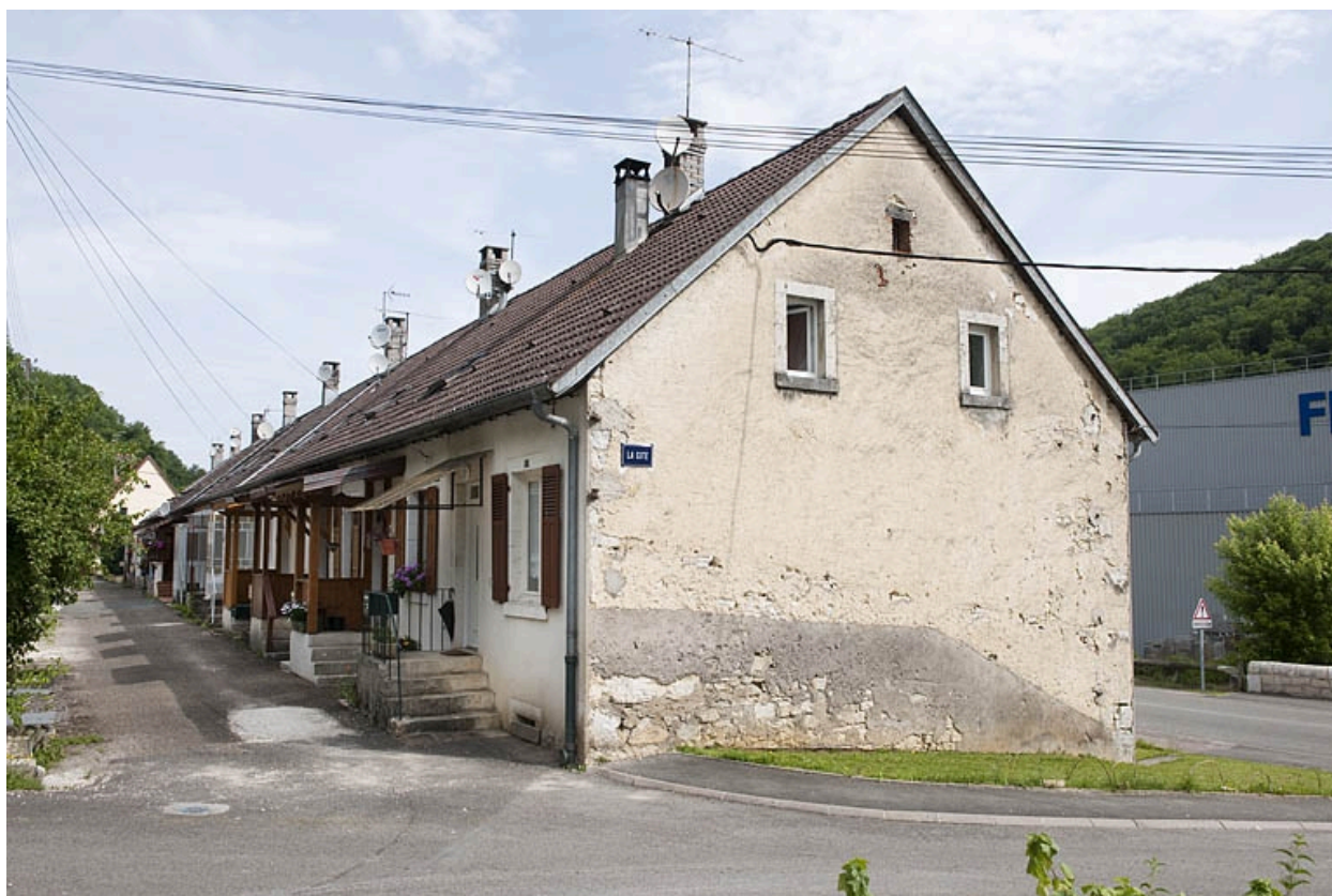
Logement d'ouvriers. Vue de trois quarts.
