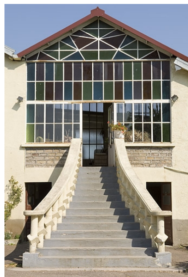
Entrée des bureaux. Phot. Jérôme Mongreville IVR43_20097000827NUC2A
