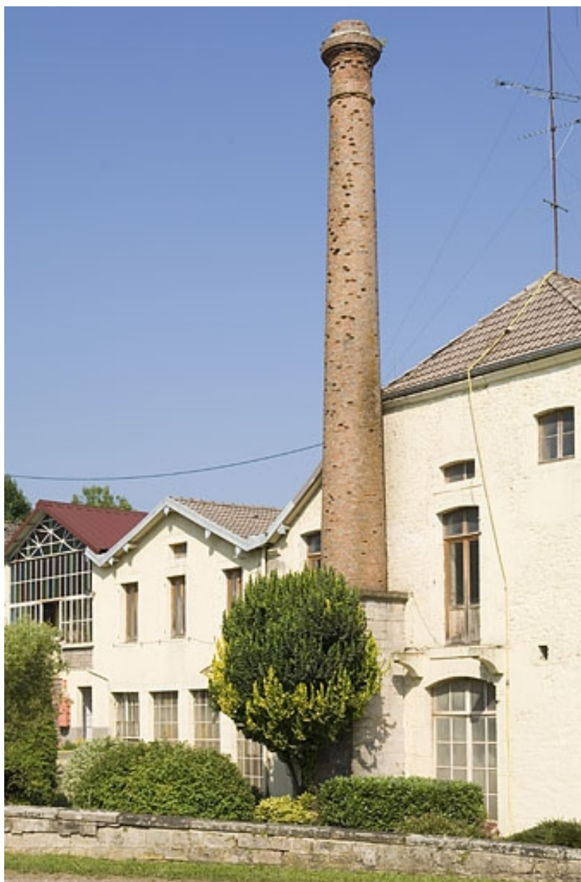
Façade est des ateliers et cheminée.
