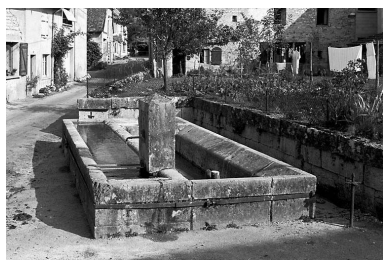
Fontaine-lavoir située rue du Pontot. Phot. Yves Sancey IVR43_19802501055X
