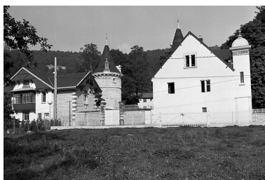
Demeure située rue du Mont d'Oeil. Phot. Yves Sancey IVR43_19802501061X
