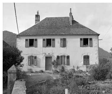
Presbytère. Phot. Yves Sancey IVR43_19802501058X
