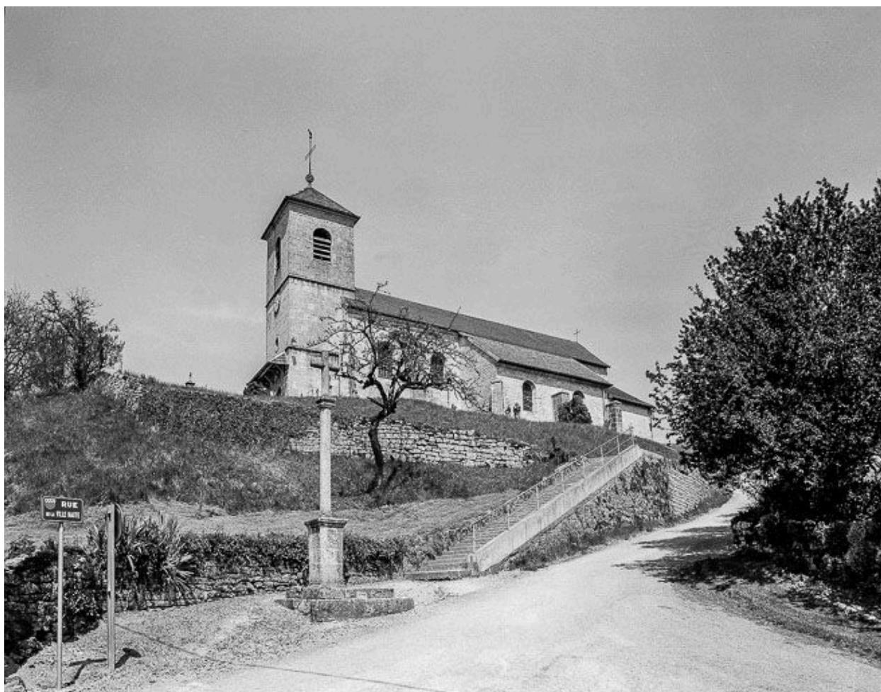
Eglise paroissiale Saint-Gengoul.
