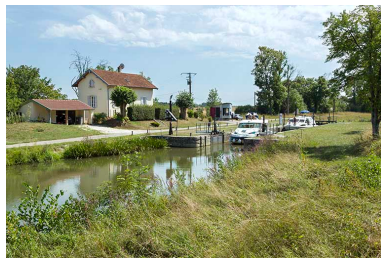
Vue aval du site d'écluse. Phot. Sonia Dourlot IVR43_20157000858NUC4A
