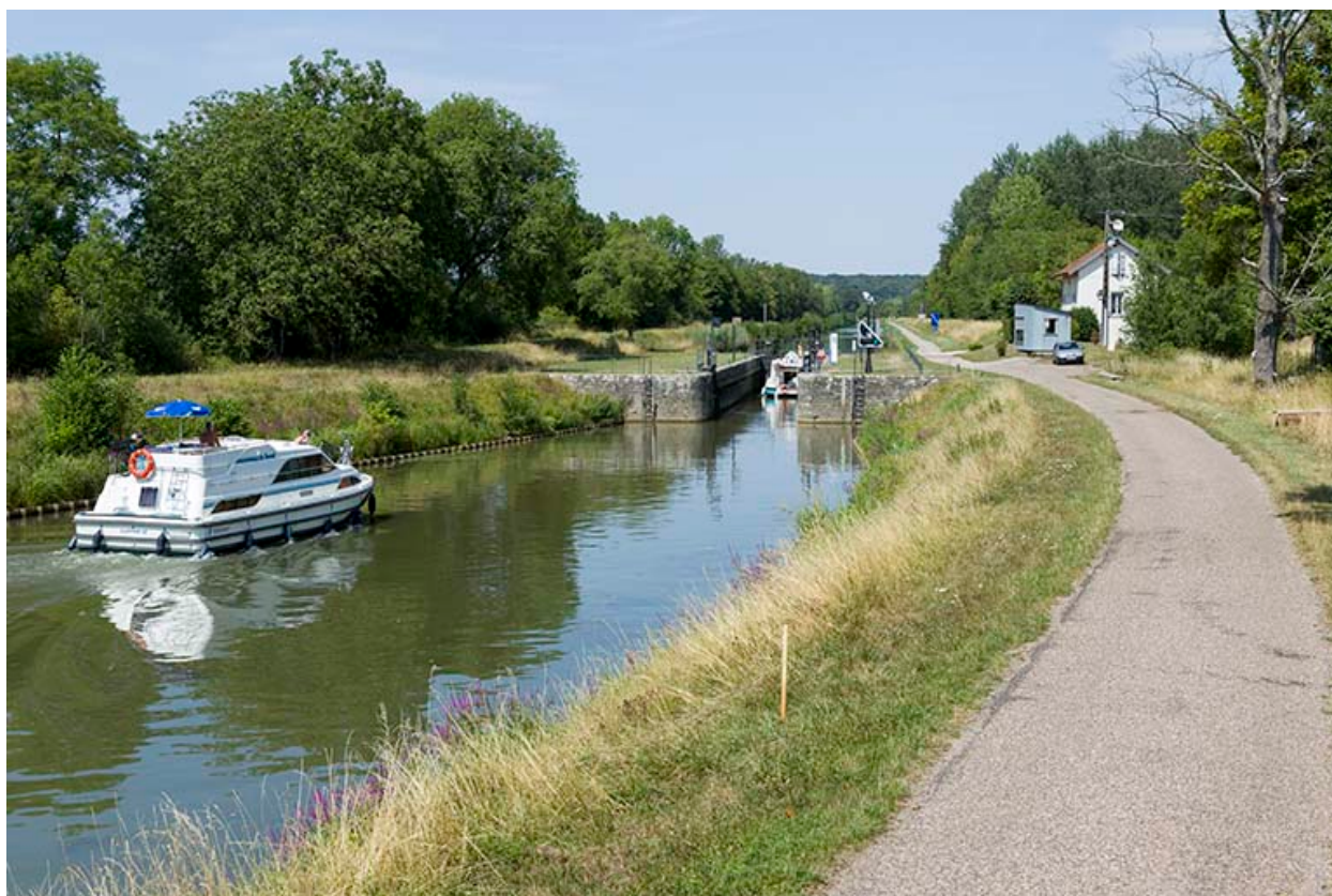
Vue amont du site d'écluse.
