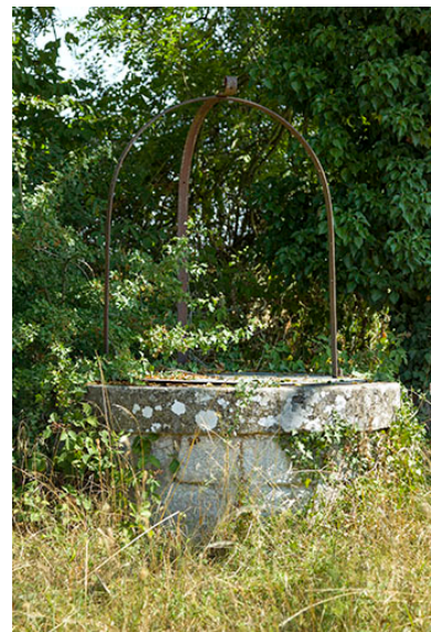
Puits dépendant du site d'écluse. Phot. Sonia Dourlot IVR43_20157000861NUC4A
