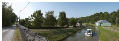
Vue d'ensemble avec à gauche, le barrage (IA58000758), au centre, la maison du barragiste et à droite,
