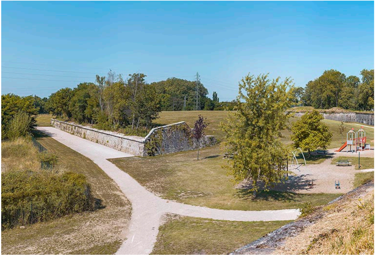
Face est de l'ouvrage.
