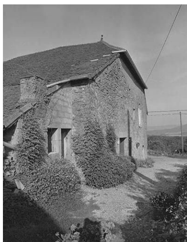
Façade latérale gauche. Phot. Dominique Dominguez IVR43_19803900017X
