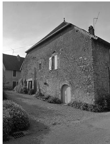
Façade latérale gauche. Phot. Dominique Dominguez IVR43_19803900247X
