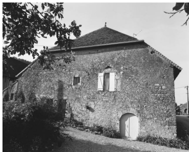
Façade latérale gauche. Phot. Dominique Dominguez IVR43_19803900016X
