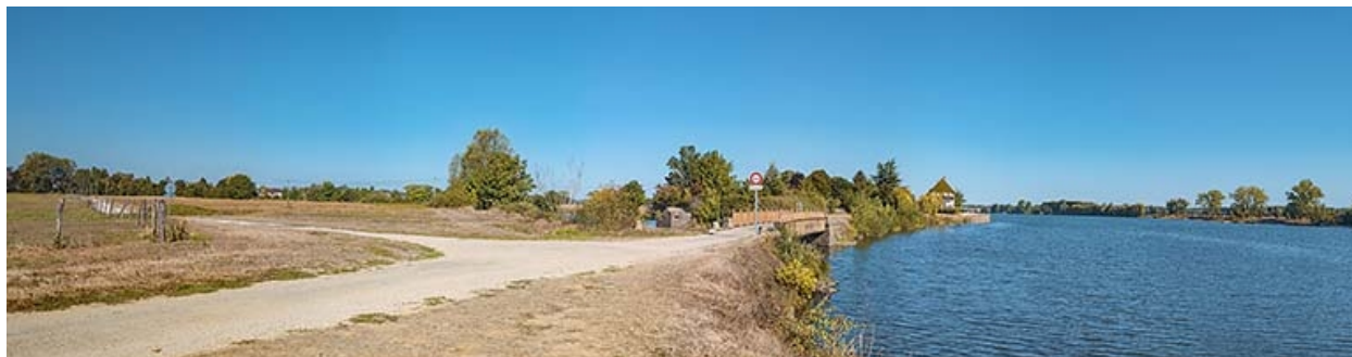
Le pont sur la Grosne et le port de Grosne, vus d'aval.
