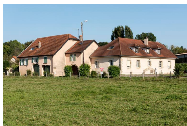
Ancien moulin aujourd'hui entreprise De Trevillers Phot. Sonia Dourlot IVR43_20167001331NUC4A
