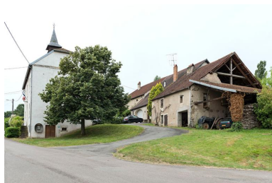
Maison commune depuis la Grande rue. A droite, la rue du Croterot. Phot. Sonia Dourlot IVR43_20167001464NUC4A
