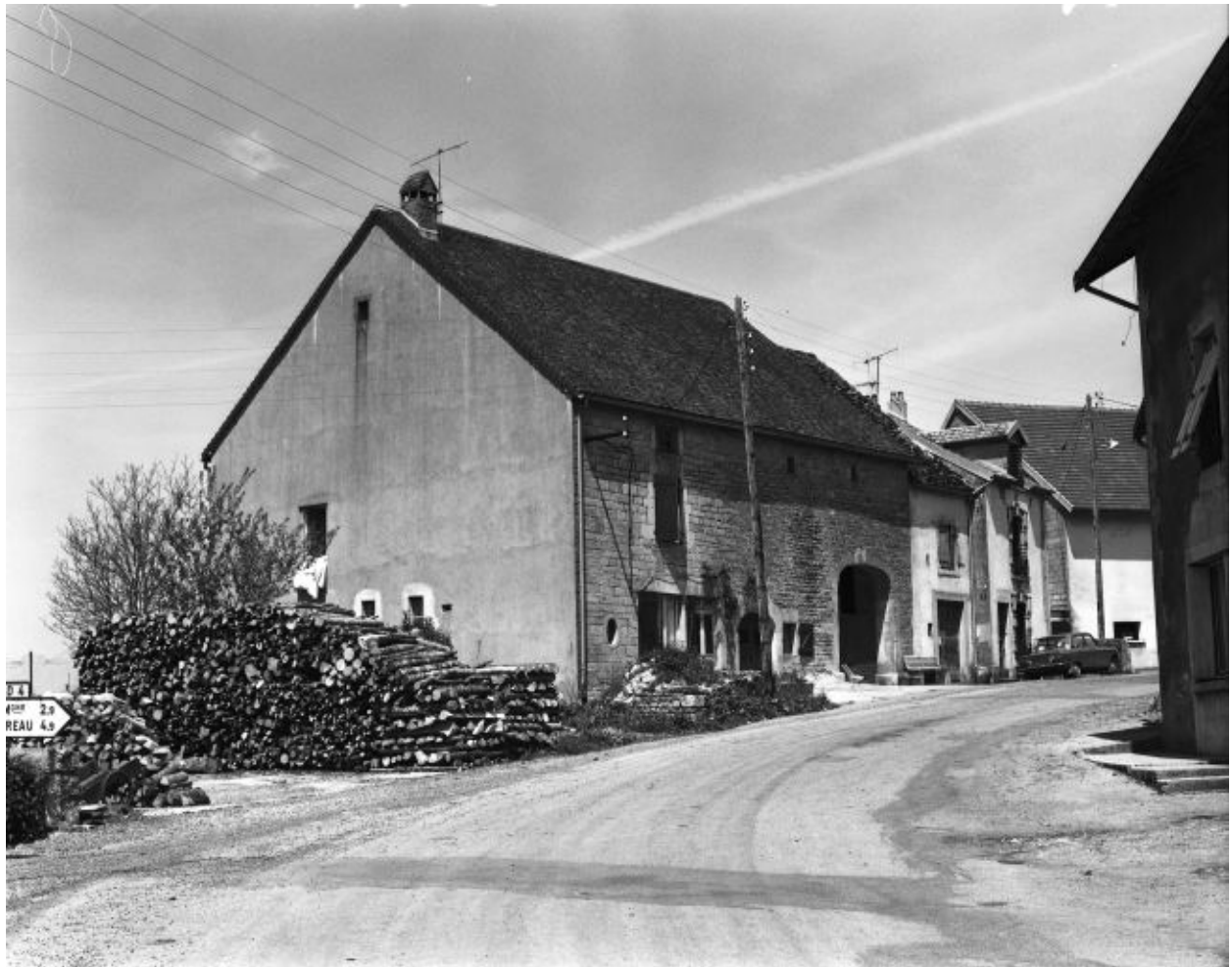
Façade antérieure vue de trois-quarts gauche en 1981.
