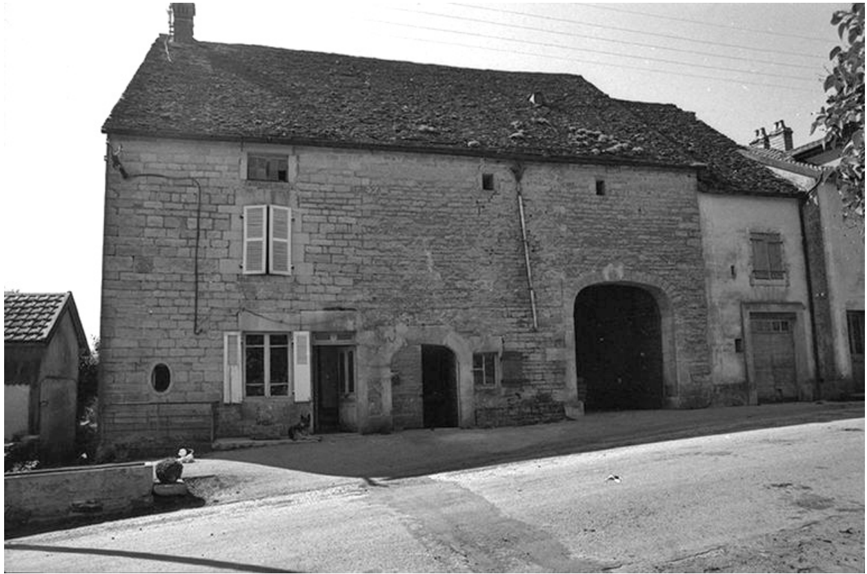
Façade antérieure vue de face en 1974.
