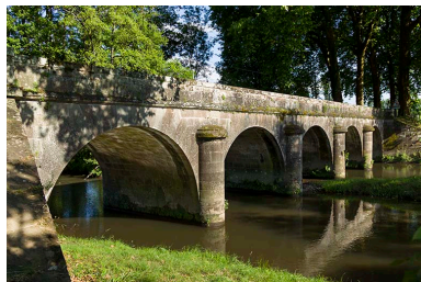
Vue du pont en aval. Phot. Sonia Dourlot IVR43_20157001156NUC2A
