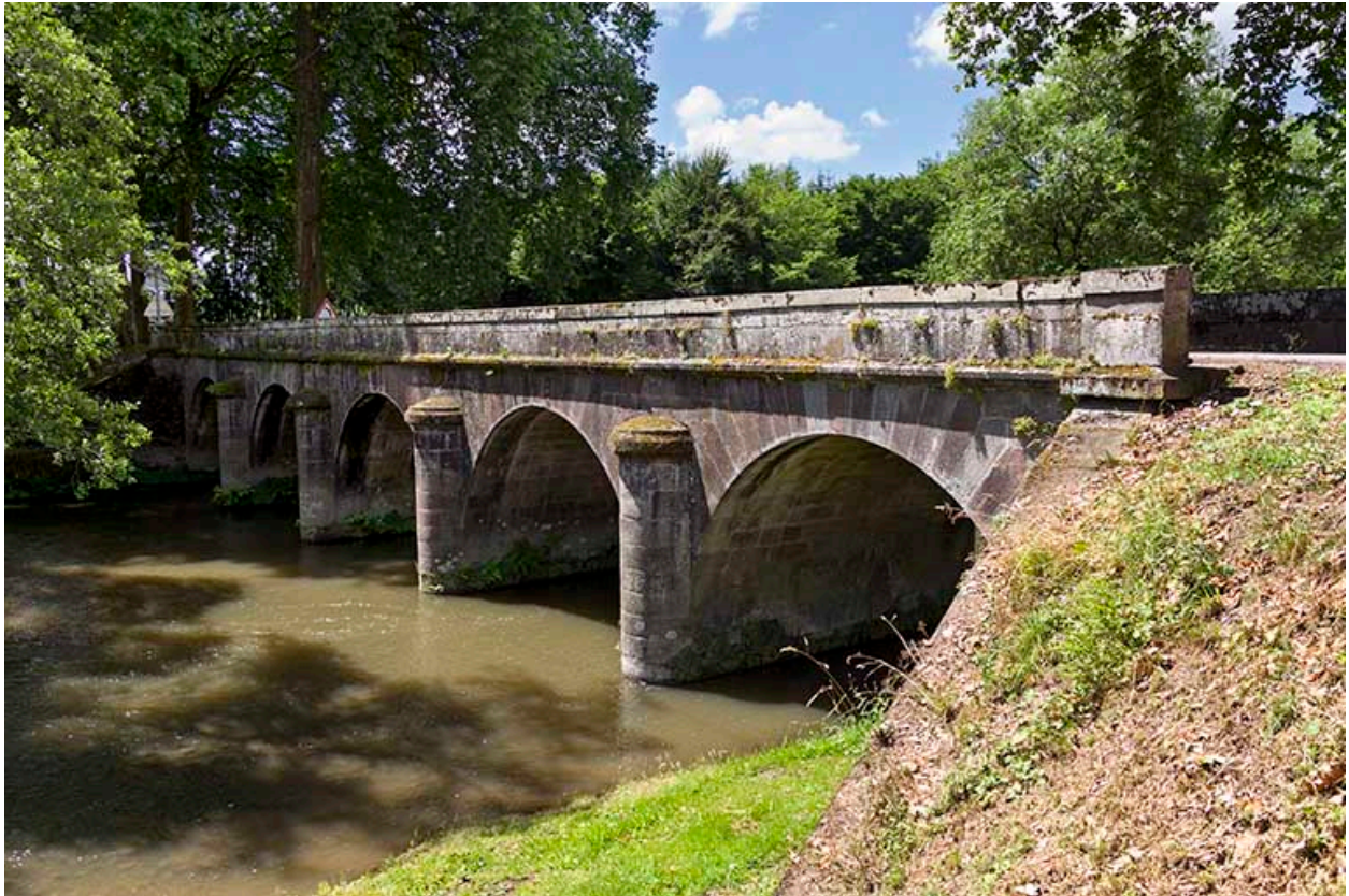
Vue du pont en amont.
