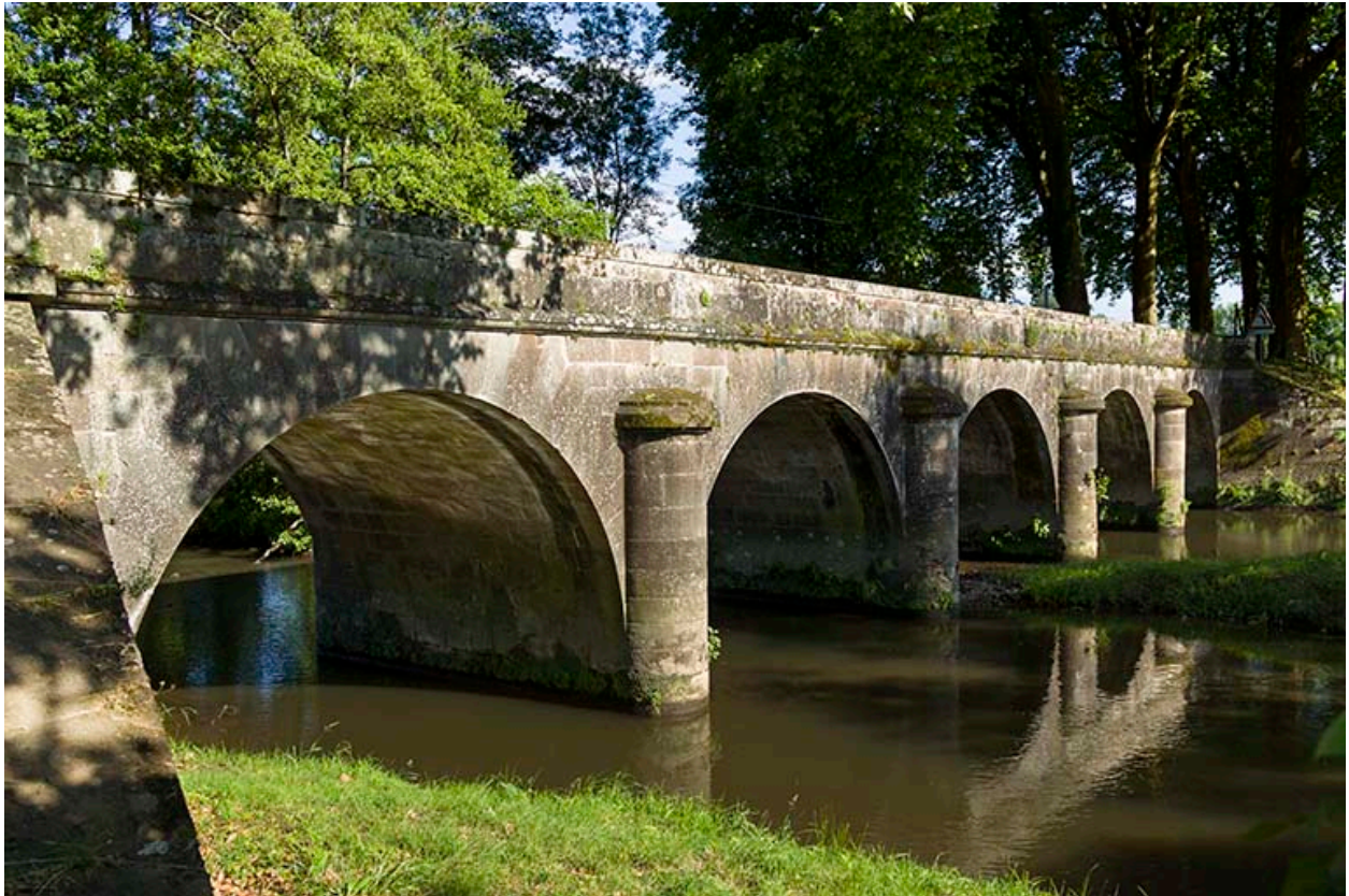
Vue du pont en aval.
