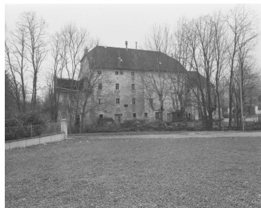
Façade postérieure du moulin. Phot. Jérôme Mongreville IVR43_19963901908X
