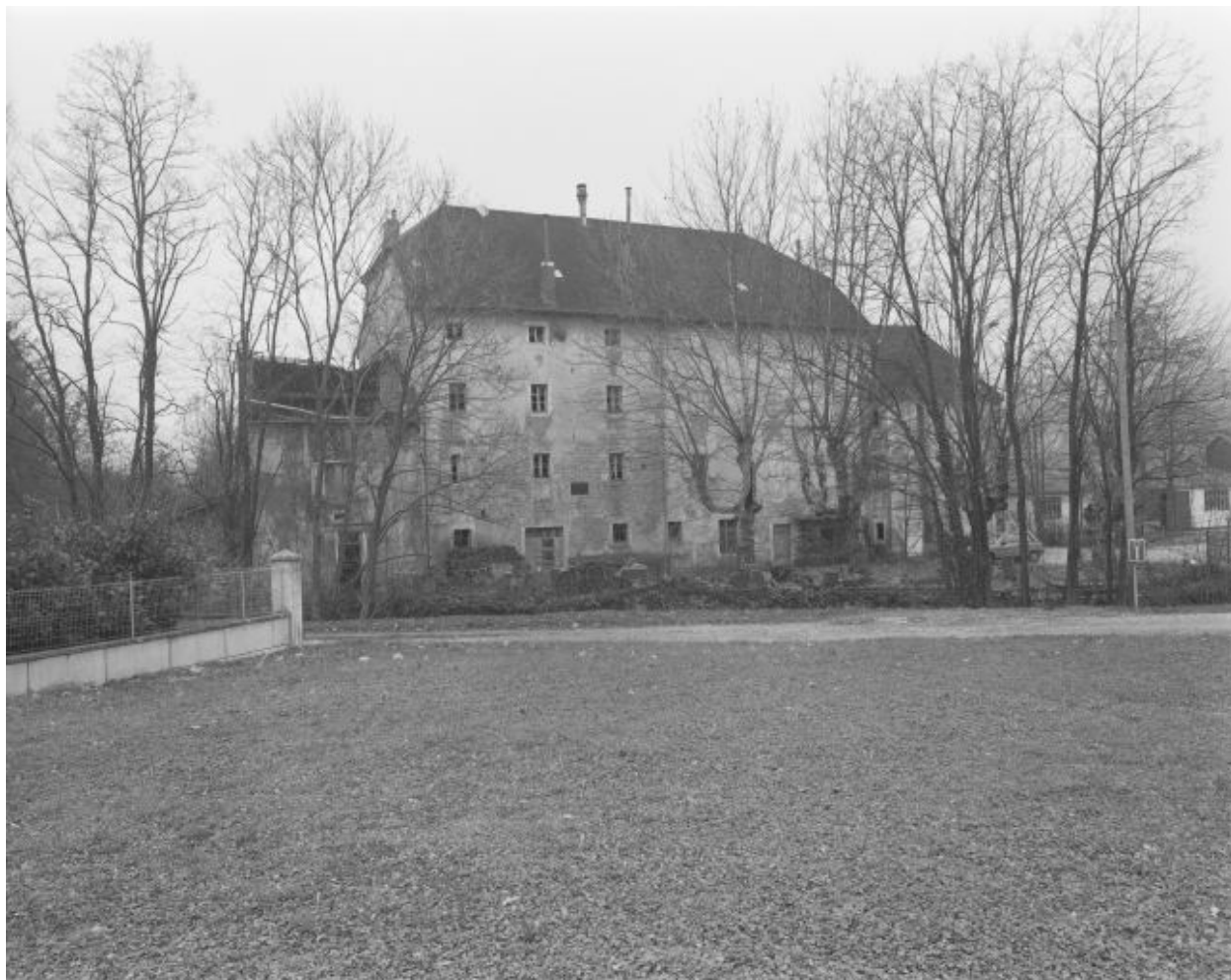
Façade postérieure du moulin.
