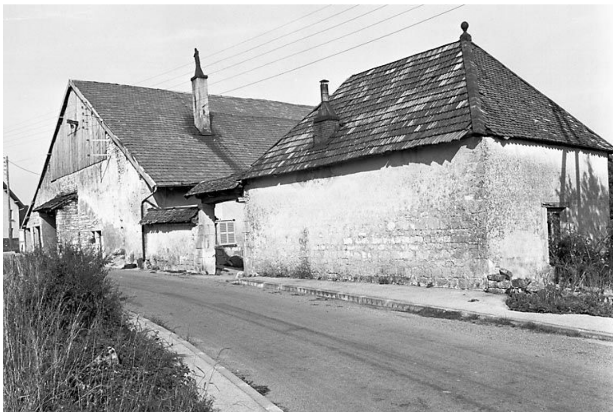
Ferme située 11 rue du Village.
