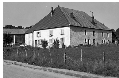
Ferme située rue du Château d'Eau. Phot. Yves Sancey IVR43_19802500862X
