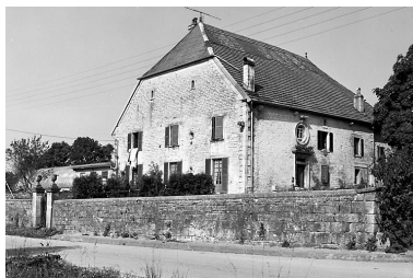
Ferme située rue du Château d'Eau. Phot. Yves Sancey IVR43_19802500865X
