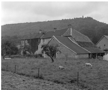
Façade postérieure. Phot. Yves Sancey IVR43_19802501155X
