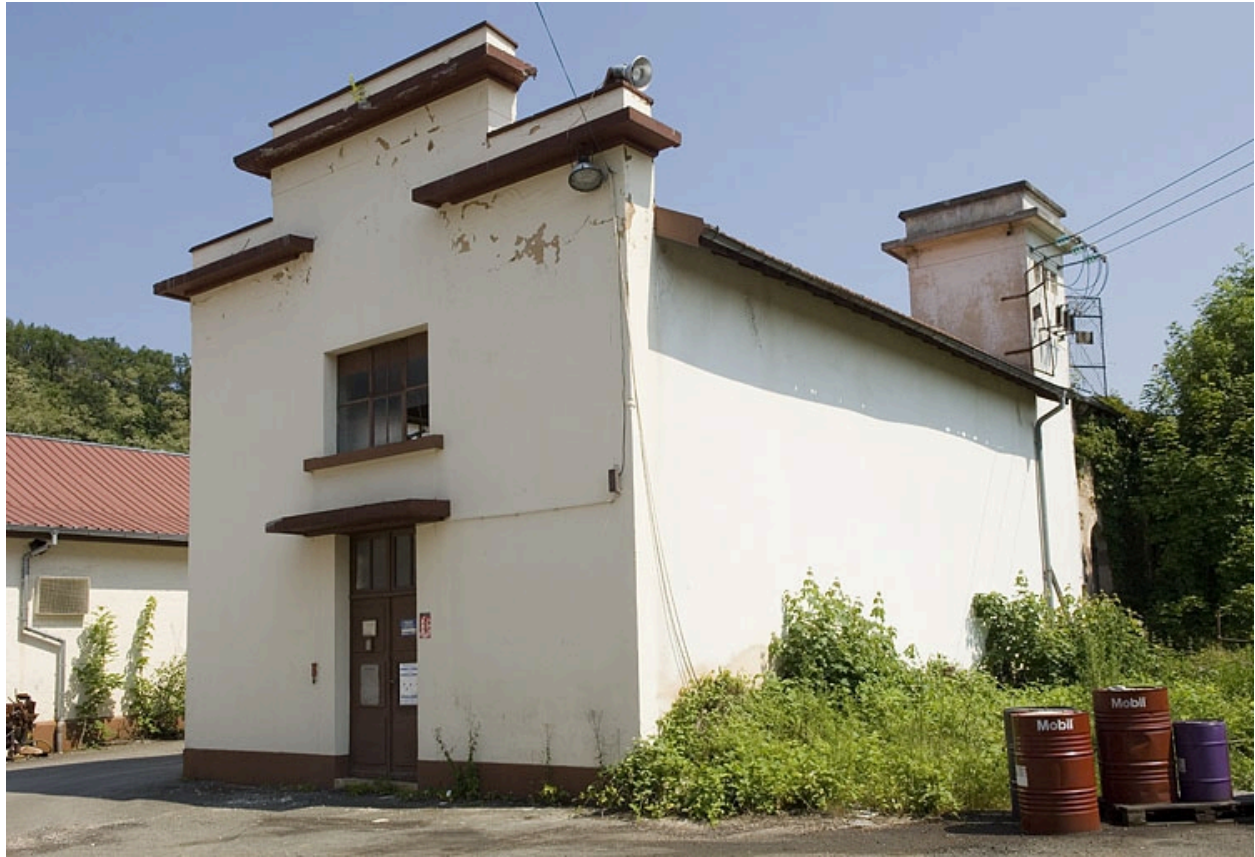
Ancien bâtiment d'eau et transformateur.
