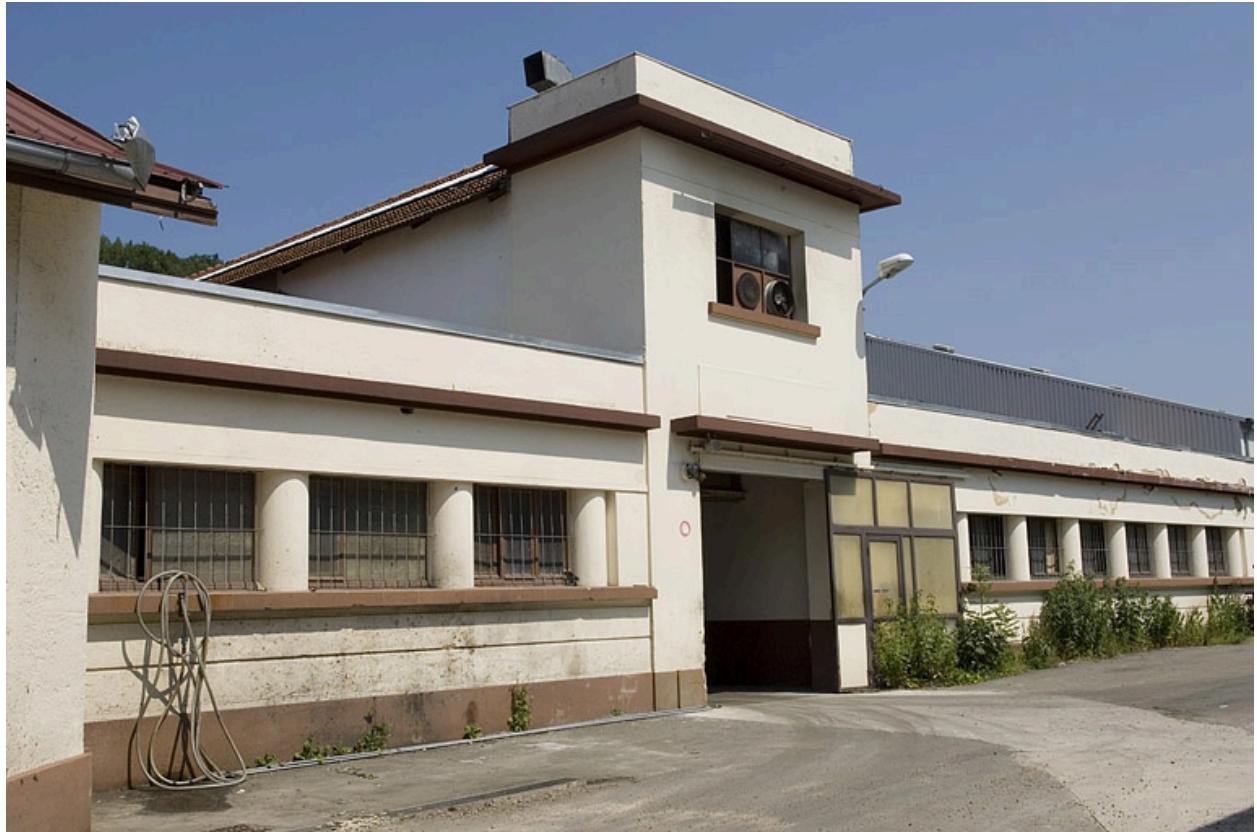
Façade antérieure de l'atelier de fabrication.
