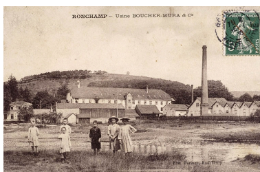
Ronchamp - Usine Boucher-Mura et Cie. Phot. IVR43_20057000620NUCA
