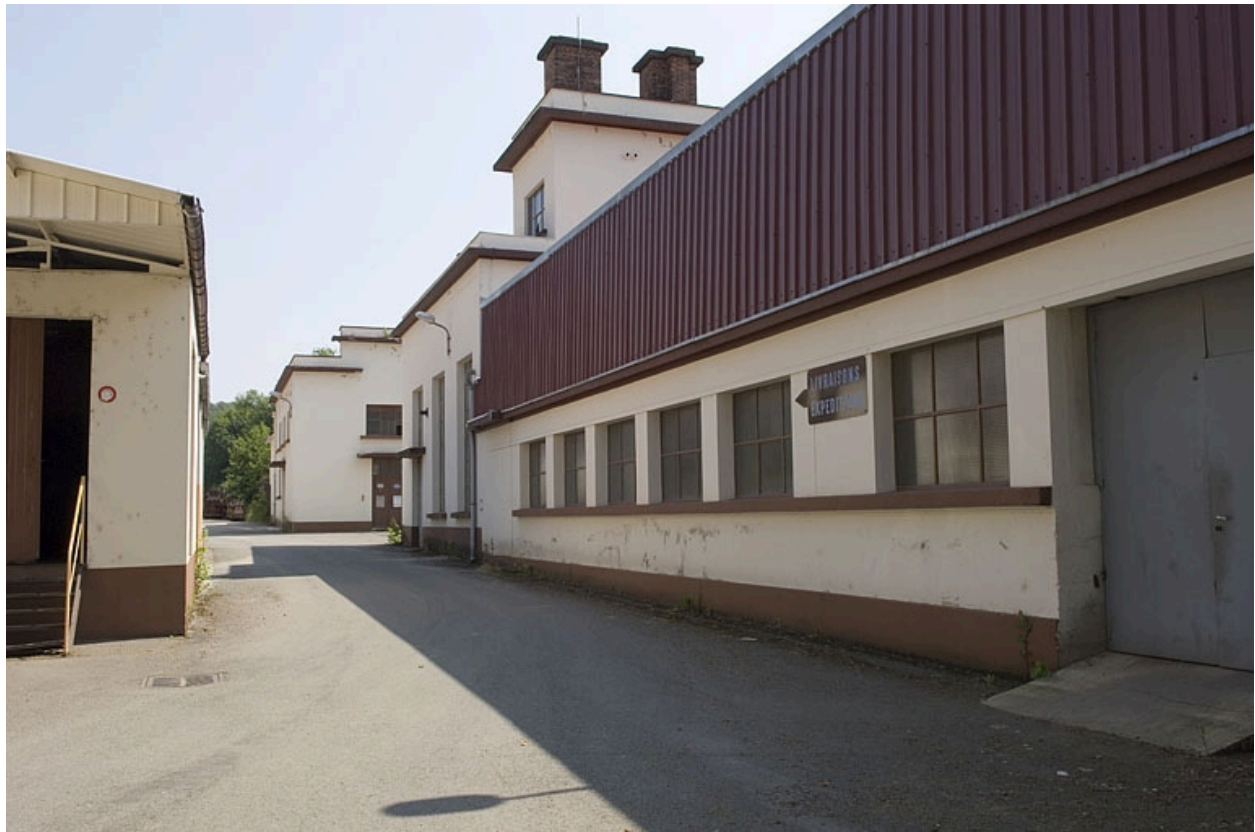
Passage entre l'atelier de fabrication et les bâtiments liés à l'énergie.
