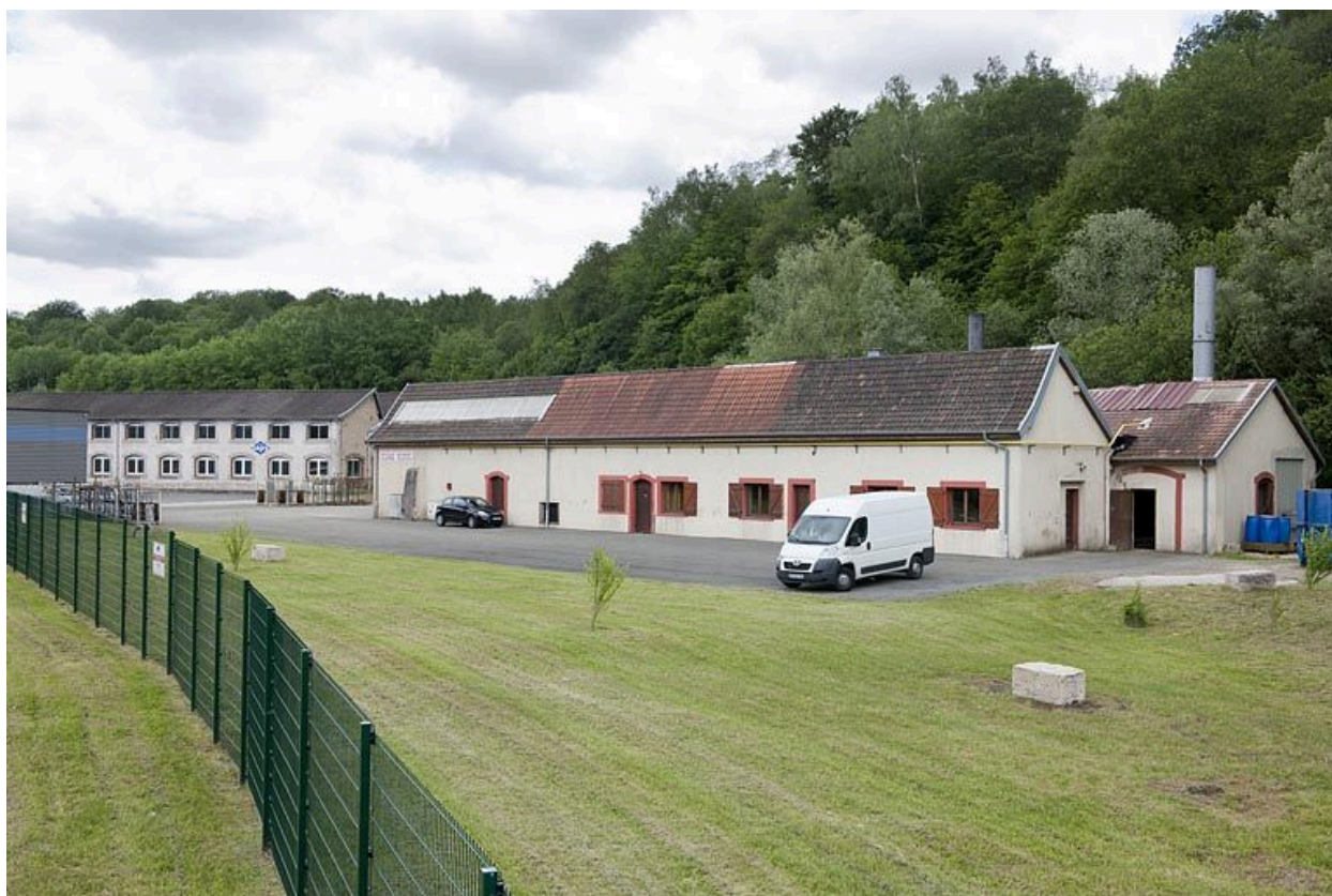
Dampierre-les-Bois, usine de petite métallurgie Japy Frères et Cie dite la Feschotte du Haut, actuellement usine de matériel d'équipement industriel des pompes Japy.
