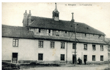
Etupes, usine de quincaillerie Japy Frères et Cie, puis magasin coopératif la Concorde : carte postale. Phot. IVR43_20122501865NUC4A
