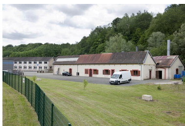
Dampierre-les-Bois, usine de petite métallurgie Japy Frères et Cie dite la Feschotte du Haut, actuellement usine de matériel d'équipement industriel des pompes Japy. Phot. Jérôme Mongreville IVR43_20122501032NUC4A
