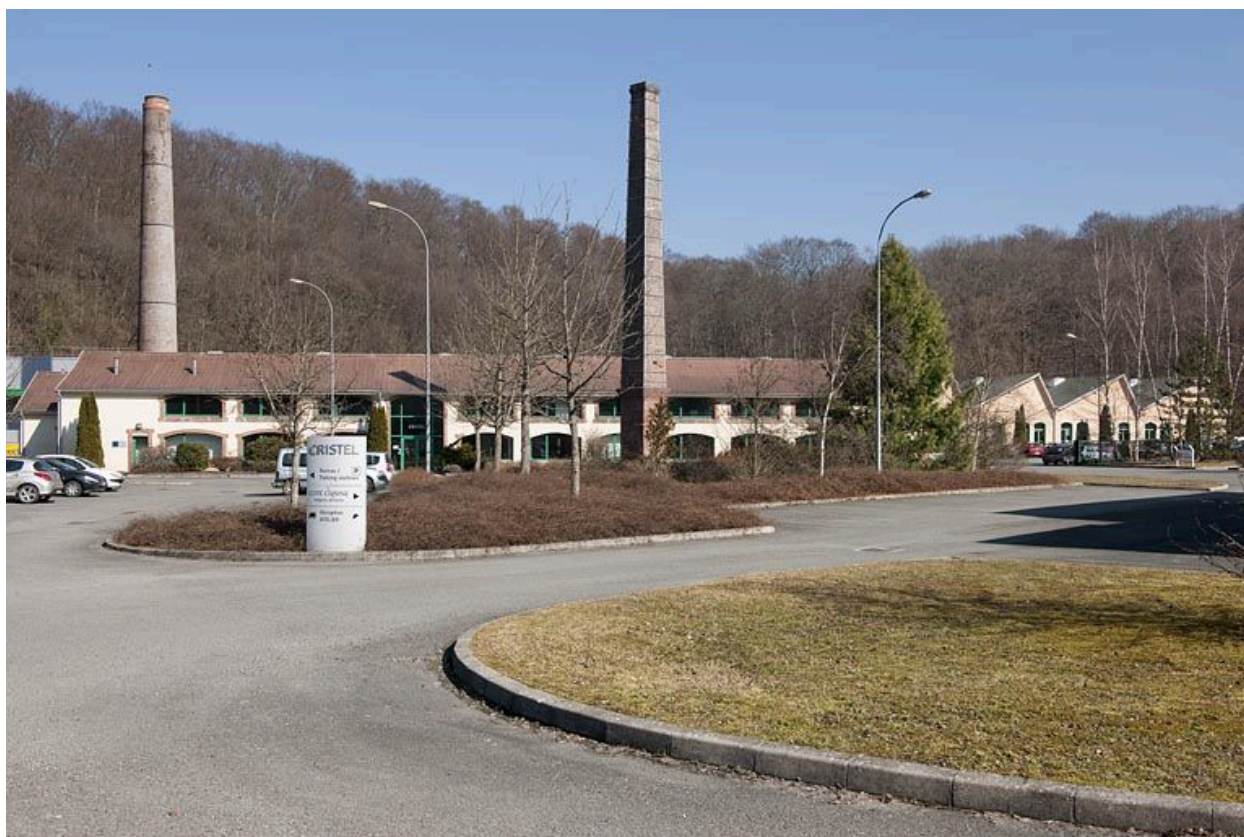
Fesches-le-Châtel, usine de ferblanterie dite la Casserie, puis usine de petite métallurgie Japy Frères et Cie, actuellement Cristel
