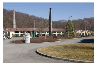
Fesches-le-Châtel, usine de ferblanterie dite la Casserie, puis usine de petite métallurgie Japy Frères et Cie, actuellement Cristel Phot. Jérôme Mongreville IVR43_20122500121NUC4A
