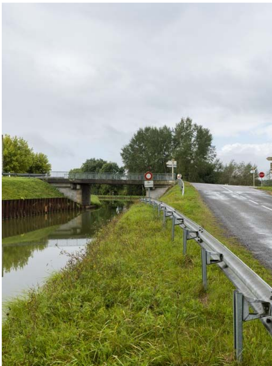
Vue d'ensemble du pont.
