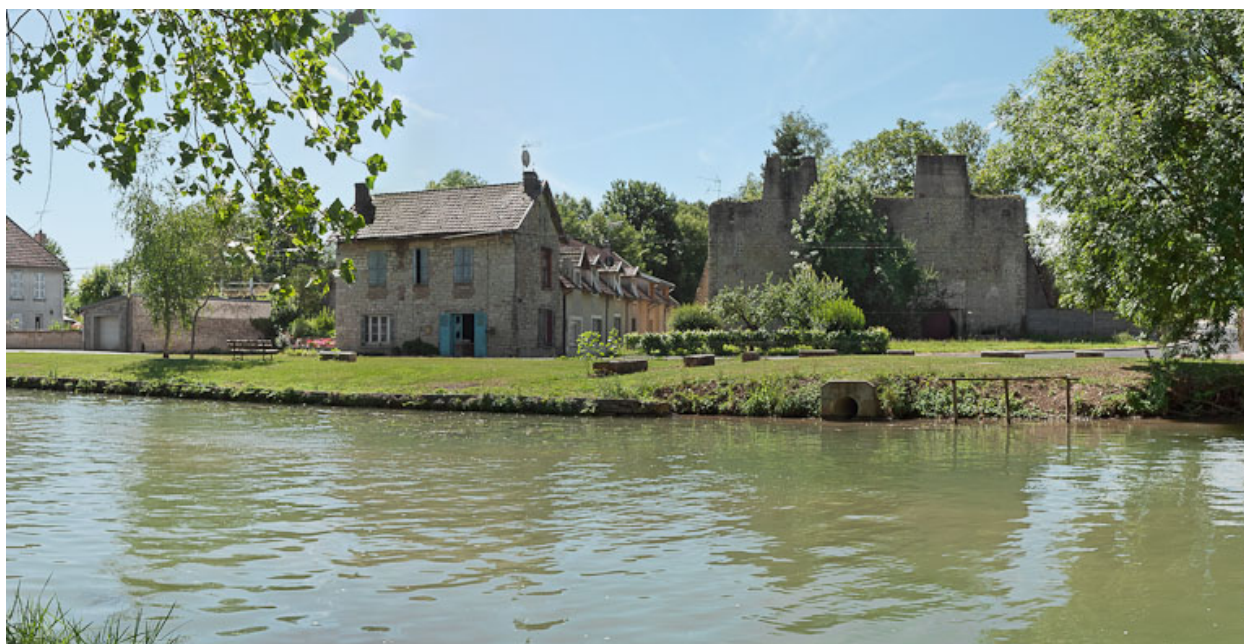
Vue générale du site depuis le canal.
