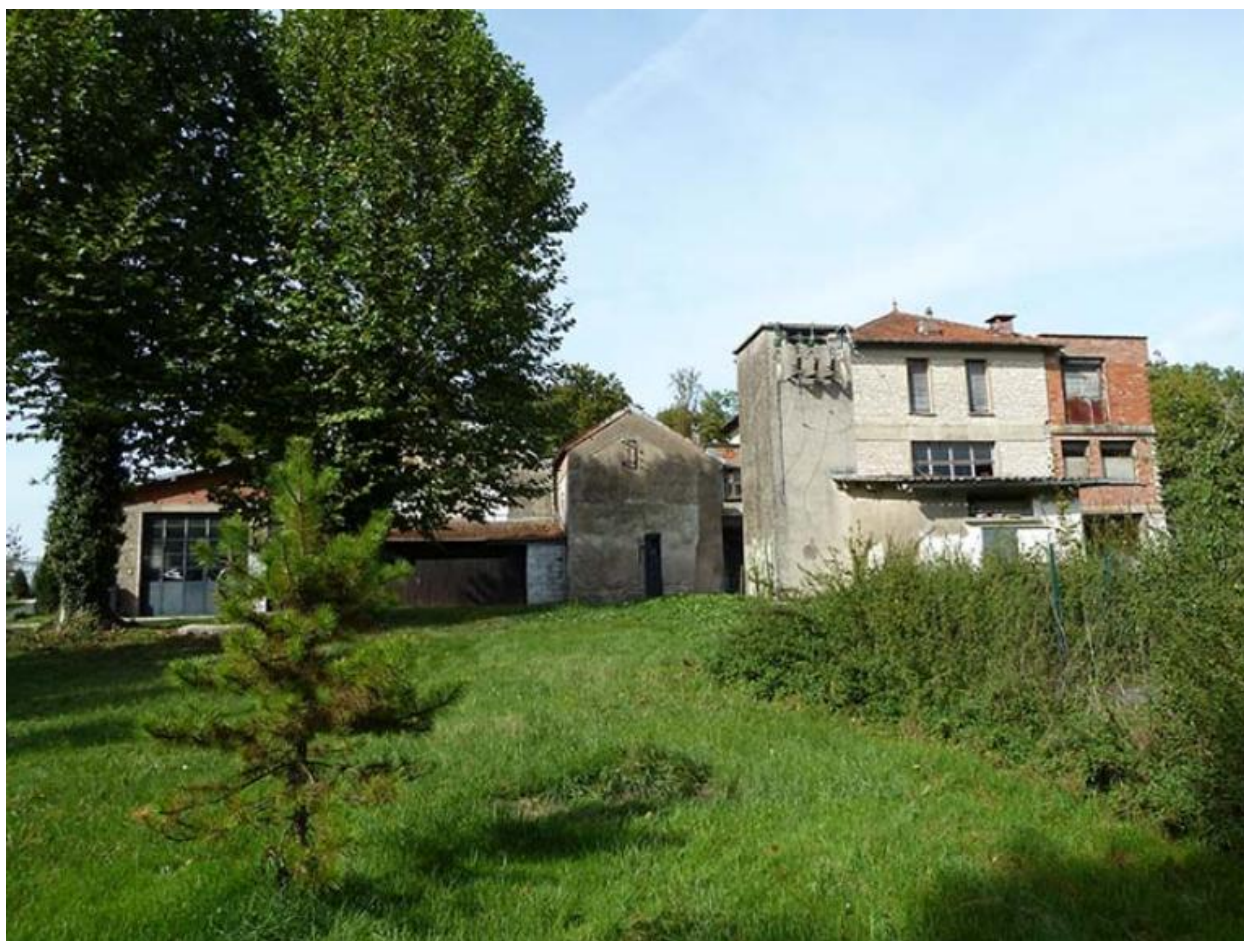
Vue sud de la laiterie
