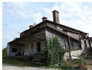
Vue générale nord ouest de la laiterie Phot. Sabrina Dalibard IVR43_20137000832NUC2A
