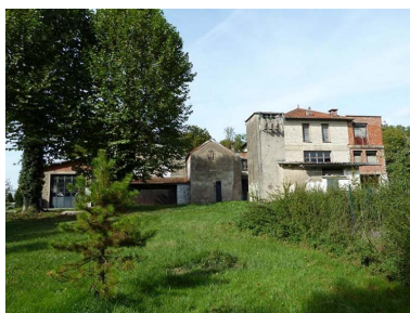
Vue sud de la laiterie Phot. Sabrina Dalibard IVR43_20137000836NUC2A
