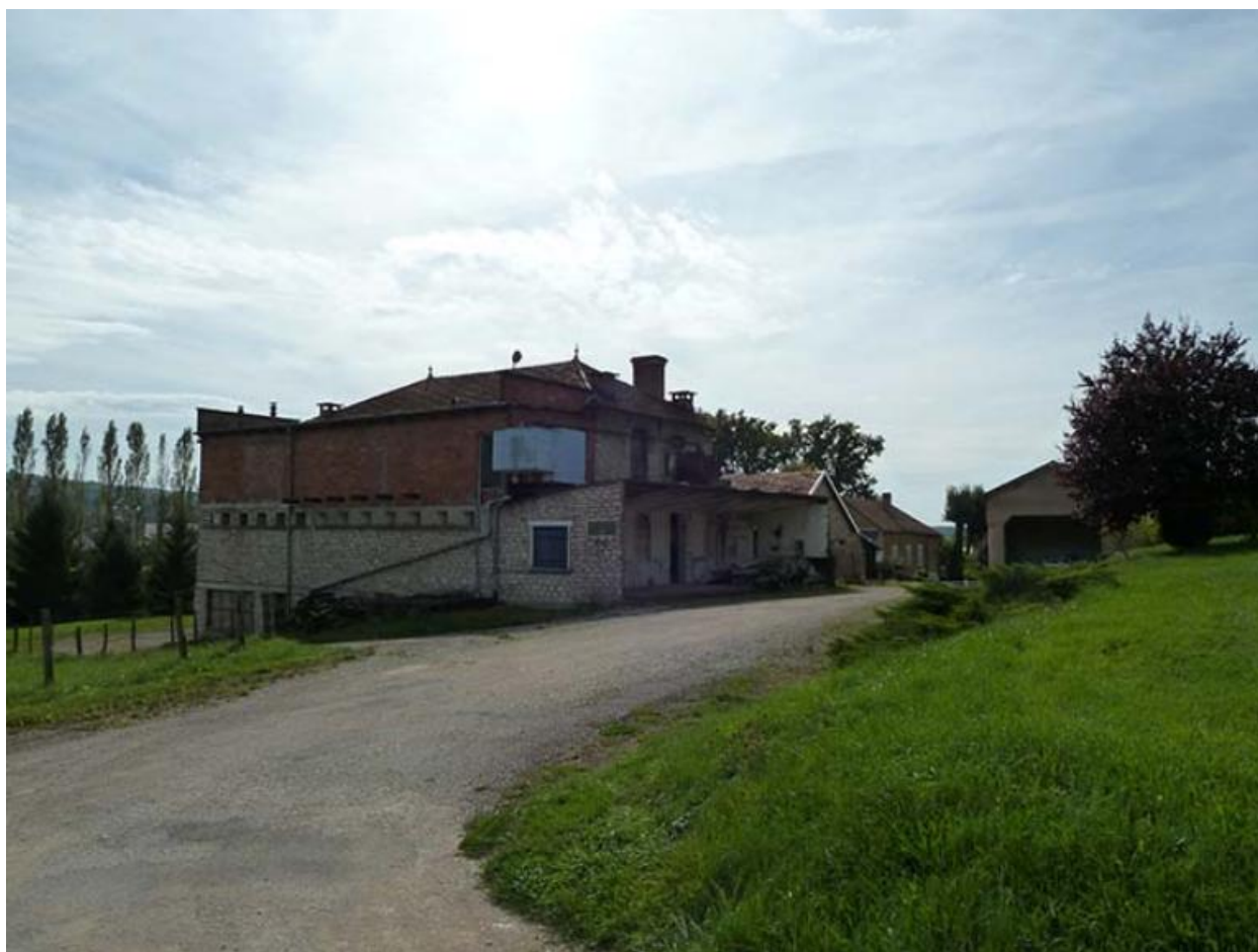
Vue générale nord-est
