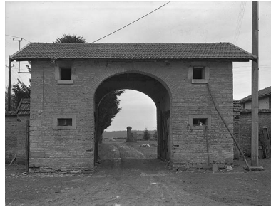
Ferme sise parcelle F1, du cadastre de 1958 : porche. Phot. Michel Thierry IVR26_19748901417V
