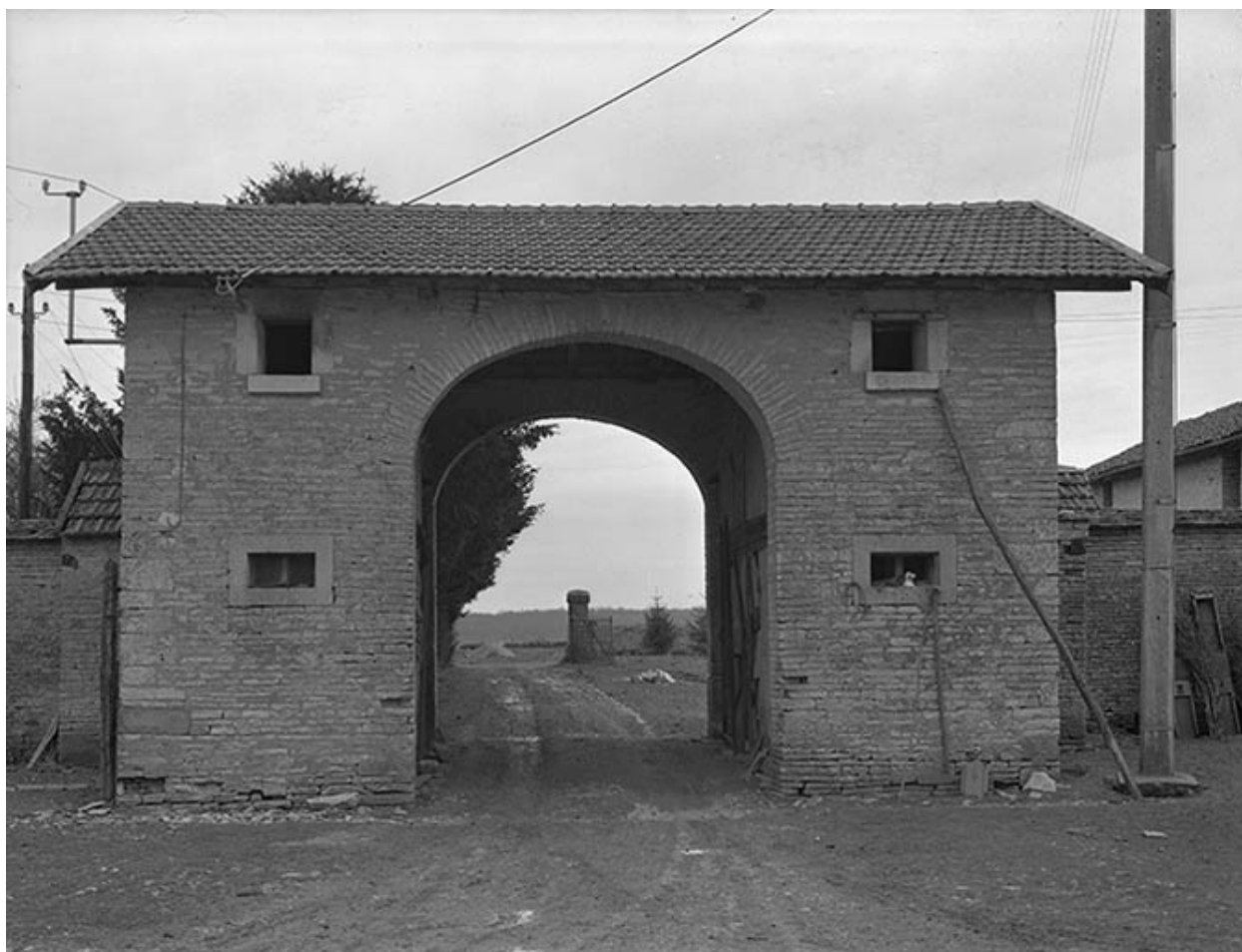
Ferme sise parcelle F1, du cadastre de 1958 : porche.
