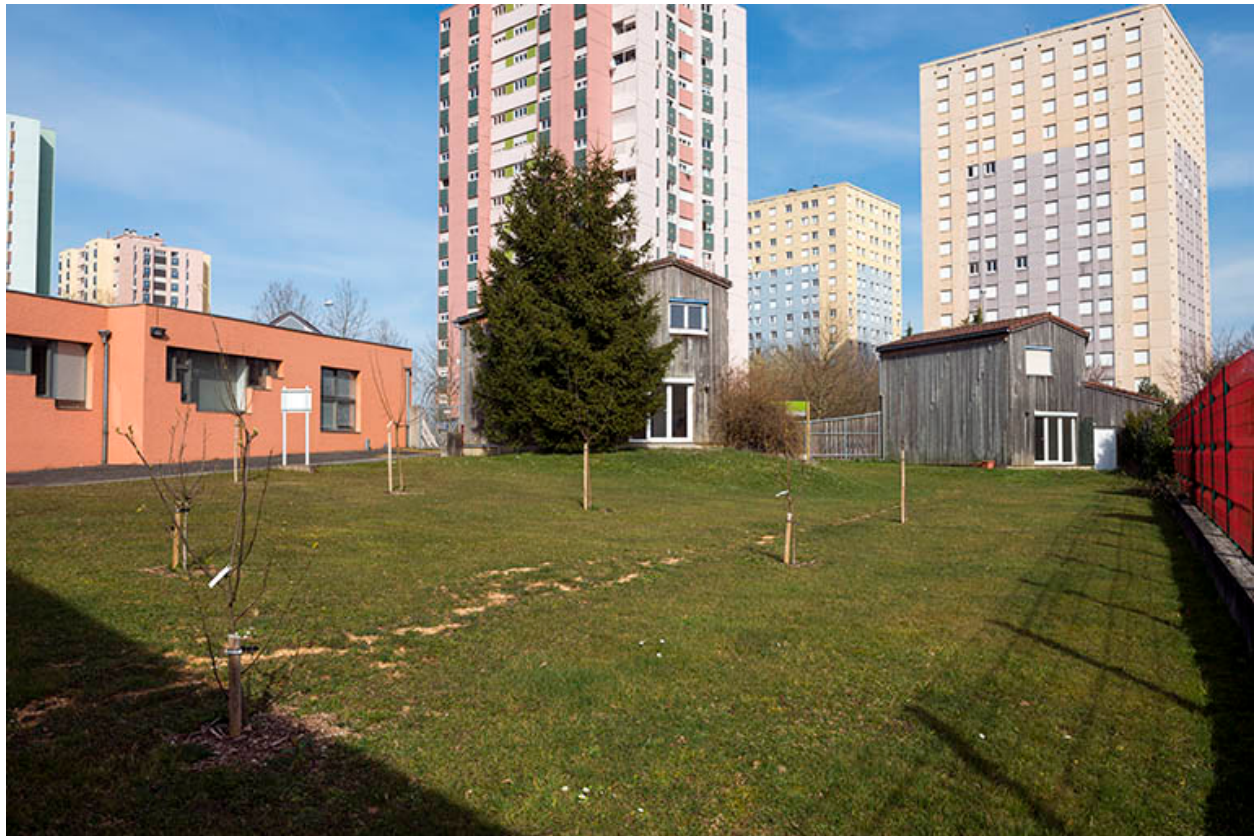
Façades postérieures des logements de fonction orientaux.
