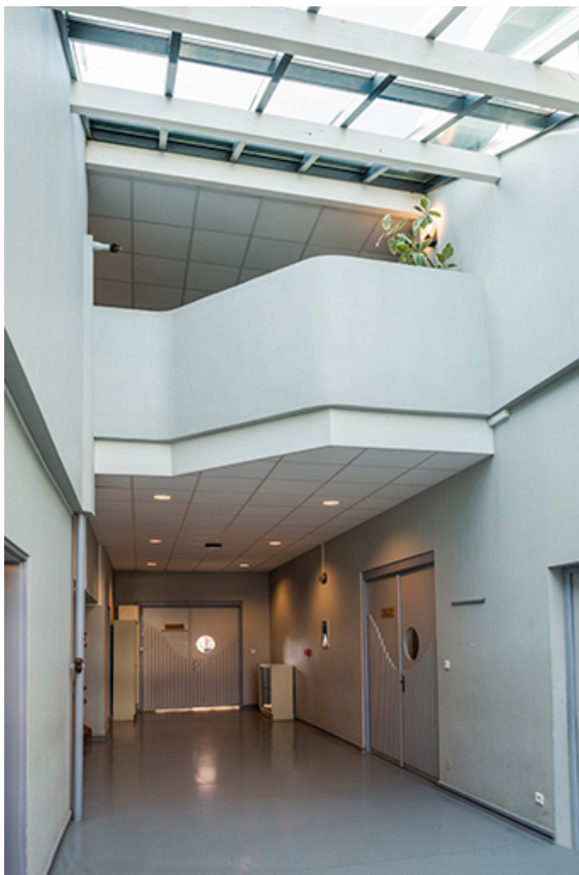
Vue intérieure du bâtiment d'administration.
