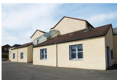
Façade sud de l'externat sud- est bordant la rue du bocage. Phot. Mary Ruffinoni IVR43_20149000044NUC4A
