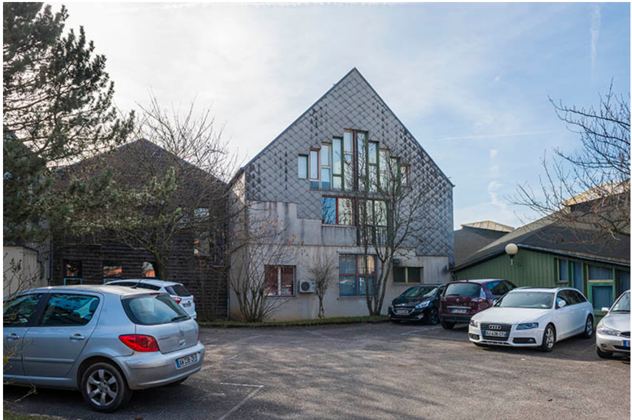
Façades postérieures est des externats du nord.
