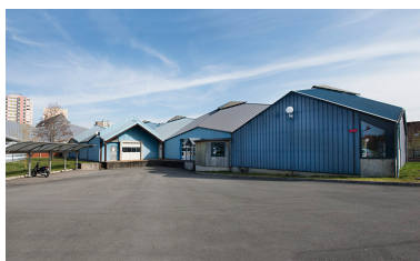
Façades postérieures ouest des ateliers de mécanique. Phot. Mary Ruffinoni IVR43_20149000074NUC4A
