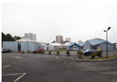
Vue d'ensemble depuis l'ouest. Phot. Mary Ruffinoni IVR43_20159000022NUC4A
