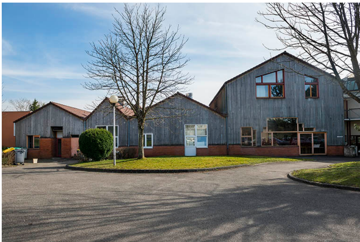
Pignons nord de la restauration.
