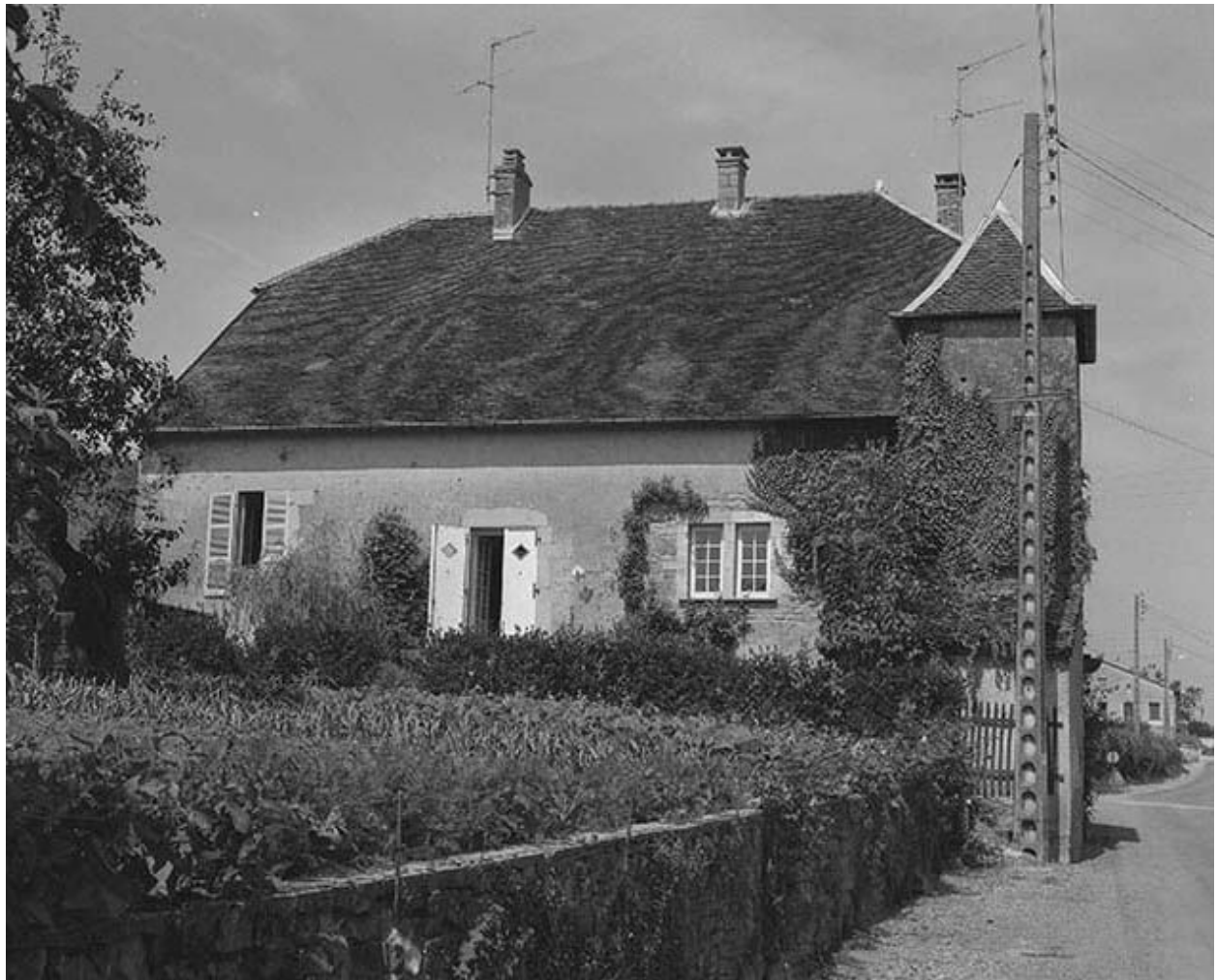
Façade latérale gauche.
