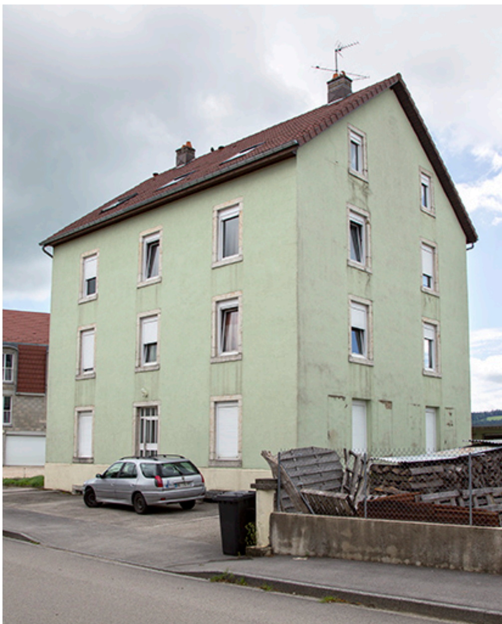
Façades antérieure et latérale droite.
