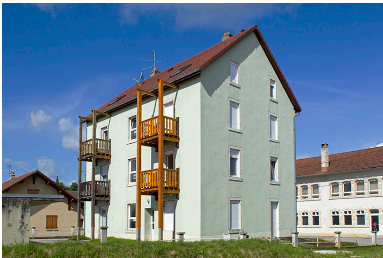
Façades postérieure et latérale gauche.
