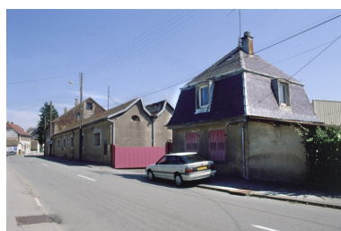
Atelier de fabrication et conciergerie depuis l'ouest. Phot. Yves Sancey IVR43_19999000070ZA
