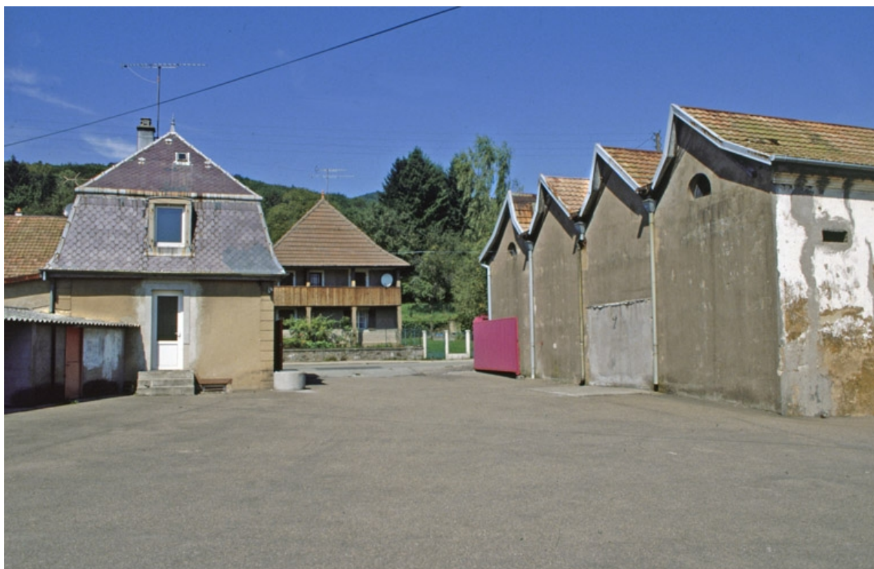
Conciergerie et murs-pignons d'un atelier de fabrication.
