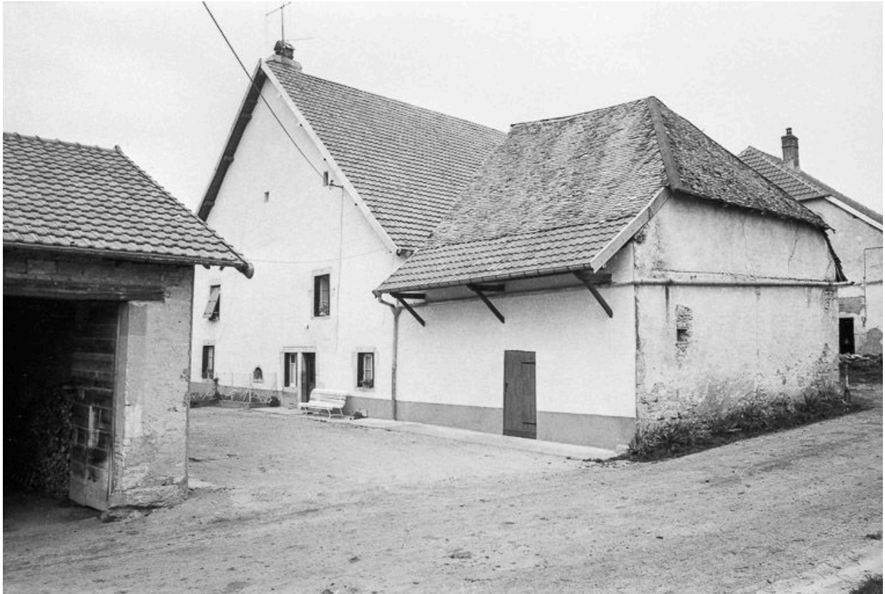
Ferme située rue du Grand Courtil.
