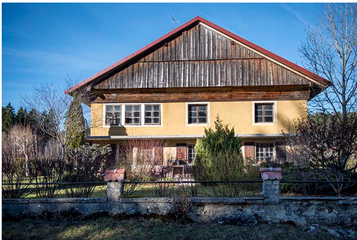
Façade latérale droite.
