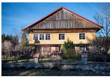
Façade latérale droite. Phot. Sonia Dourlot IVR43_20162501654NUC4A
