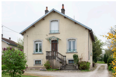
Vue générale de la maison. Phot. Jérôme Mongreville IVR43_20177000671NUC4A
