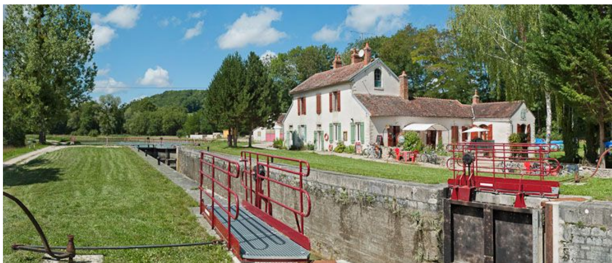
Vue d'ensemble du site d'écluse.
