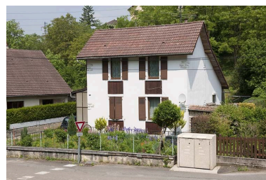
Maison individuelle. Vue de trois quarts droite. Phot. Jérôme Mongreville IVR43_20122501067NUC4A
