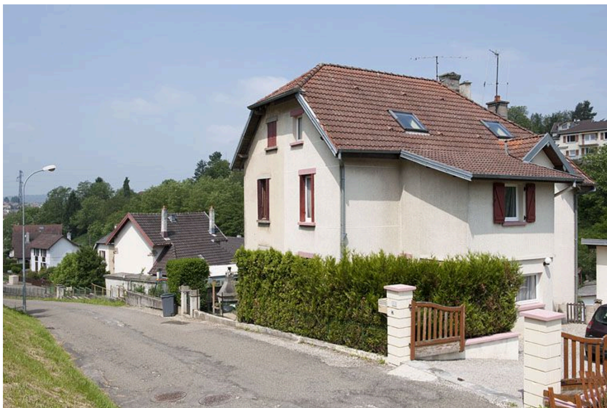
Maison jumelée. Vue de trois quarts droite.
