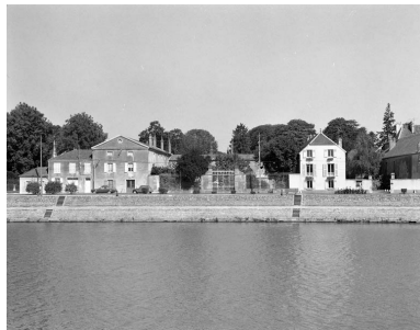
Vue d'ensemble depuis le quai Mavia. Phot. Yves Sancey IVR43_19887000070X
