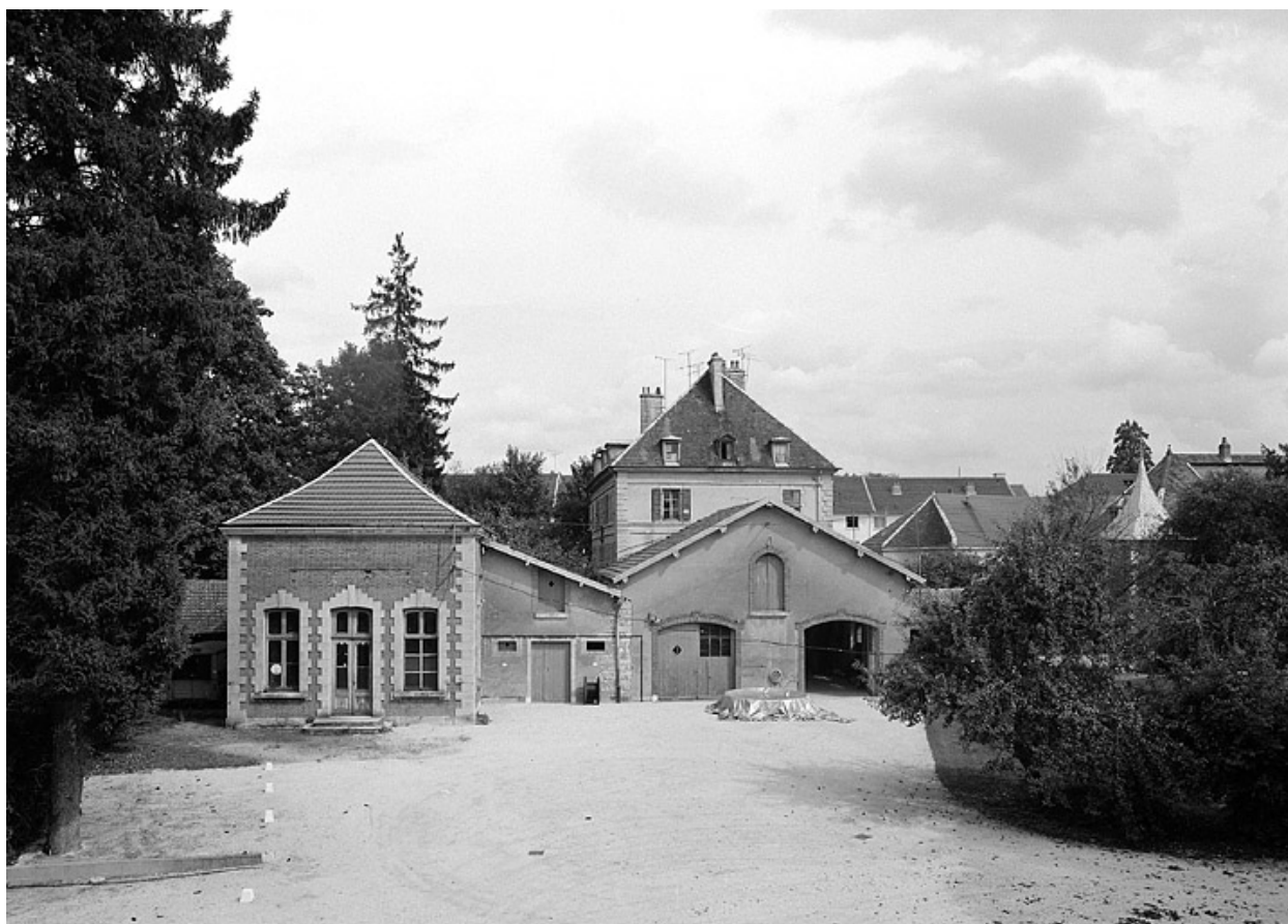
Remises et dépendances à droite de l'arrière-cour.
