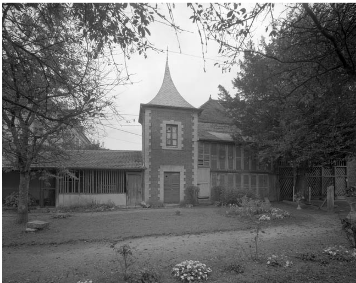
Bûchers et pigeonnier à droite de l'arrière-cour.
