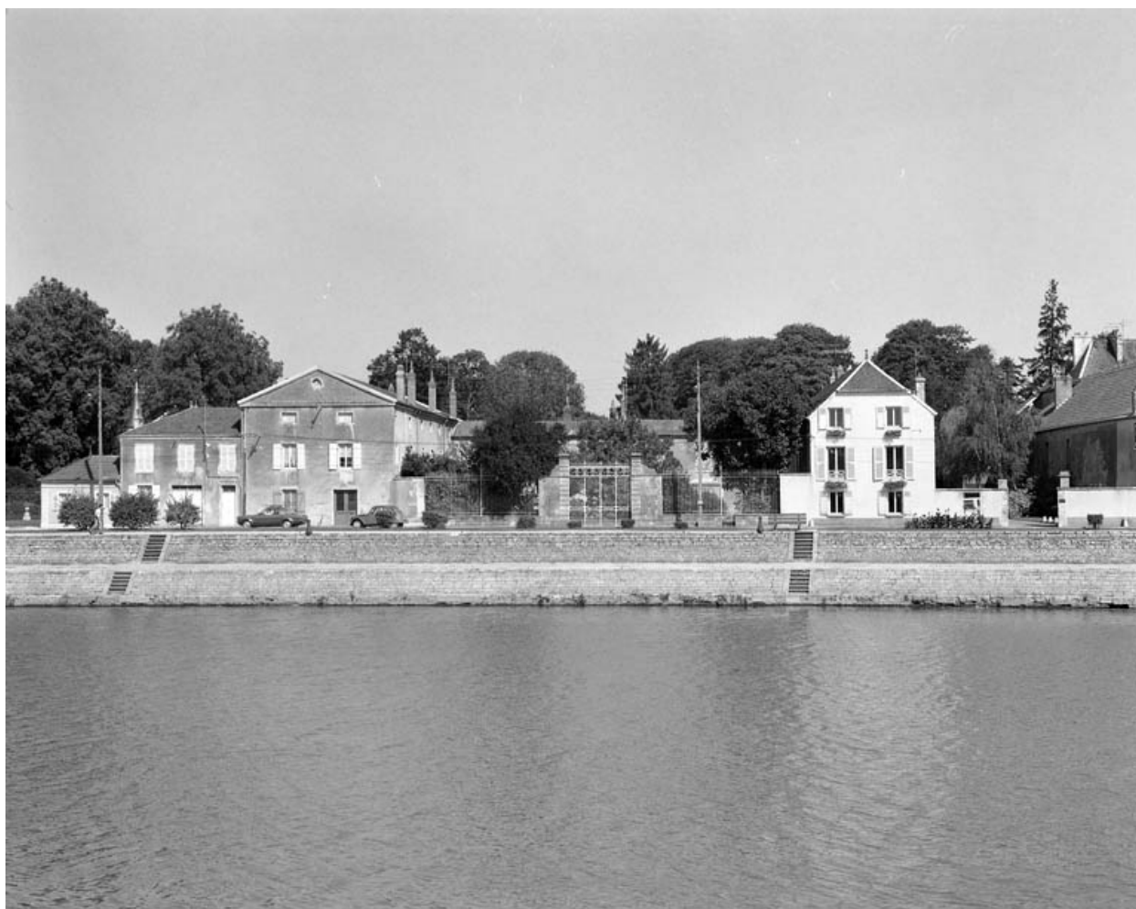
Vue d'ensemble depuis le quai Mavia.
