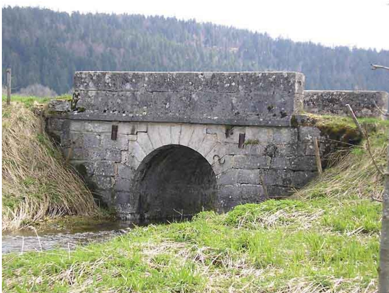
Pont situé au lieu-dit Le Maréchet.
