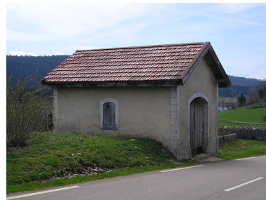
Remise de matériel incendie située au lieu-dit Le Crétet. Phot. Marie-Pierre Reynet IVR43_20083900167NUC1A
