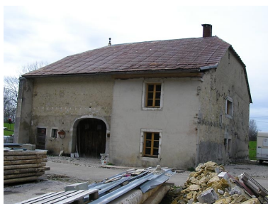
Ferme située au lieu- dit Sous le Mont noir. Phot. Marie-Pierre Reynet IVR43_20083900182NUC1A
