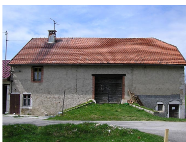
Ferme située au lieu-dit Le Maréchet. Phot. Marie-Pierre Reynet IVR43_20083900176NUC1A
