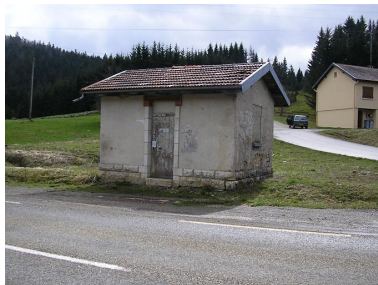
Halte de voyageurs située au lieu-dit Les Martins. Phot. Marie-Pierre Reynet IVR43_20083900108NUC1A
