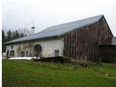
Ferme située au lieu-dit Les Martins. Phot. Marie-Pierre Reynet IVR43_20083900131NUC1A
