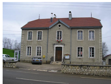
Mairie, école primaire, située au lieu-dit Les Thévenins. Phot. Marie-Pierre Reynet IVR43_20083900154NUC1A
