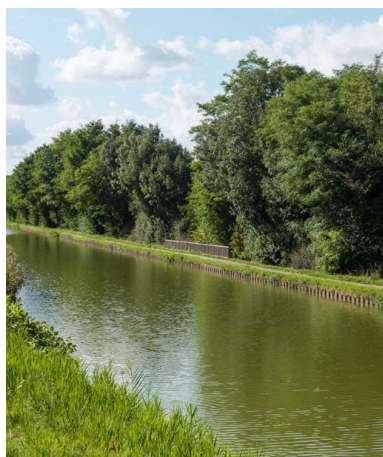
Vue de l'aqueduc-déversoir. Phot. Pierre-Marie Barbe-Richaud IVR26_20177100259NUC2A
