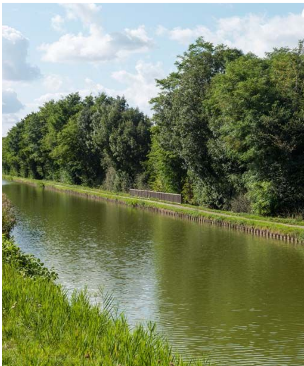
Vue de l'aqueduc-déversoir.
