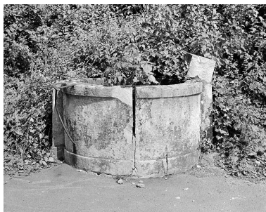
Puits. Il possédait des piédroits, aujourd'hui ruinés, supportant un linteau auquel était accroché la potence. Phot. Jérôme Mongreville IVR43_19872500804X
