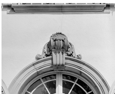
Façade sud. Détail d'une fenêtre du rez-de-chaussée. Phot. Jérôme Mongreville IVR43_19872500803X
