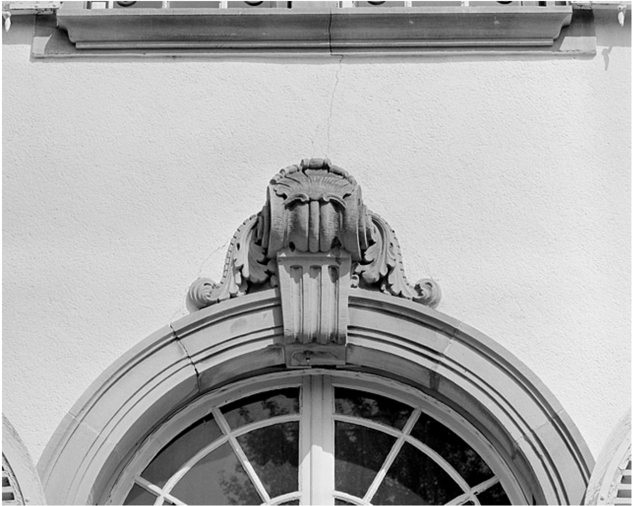
Façade sud. Détail d'une fenêtre du rez-de-chaussée.
