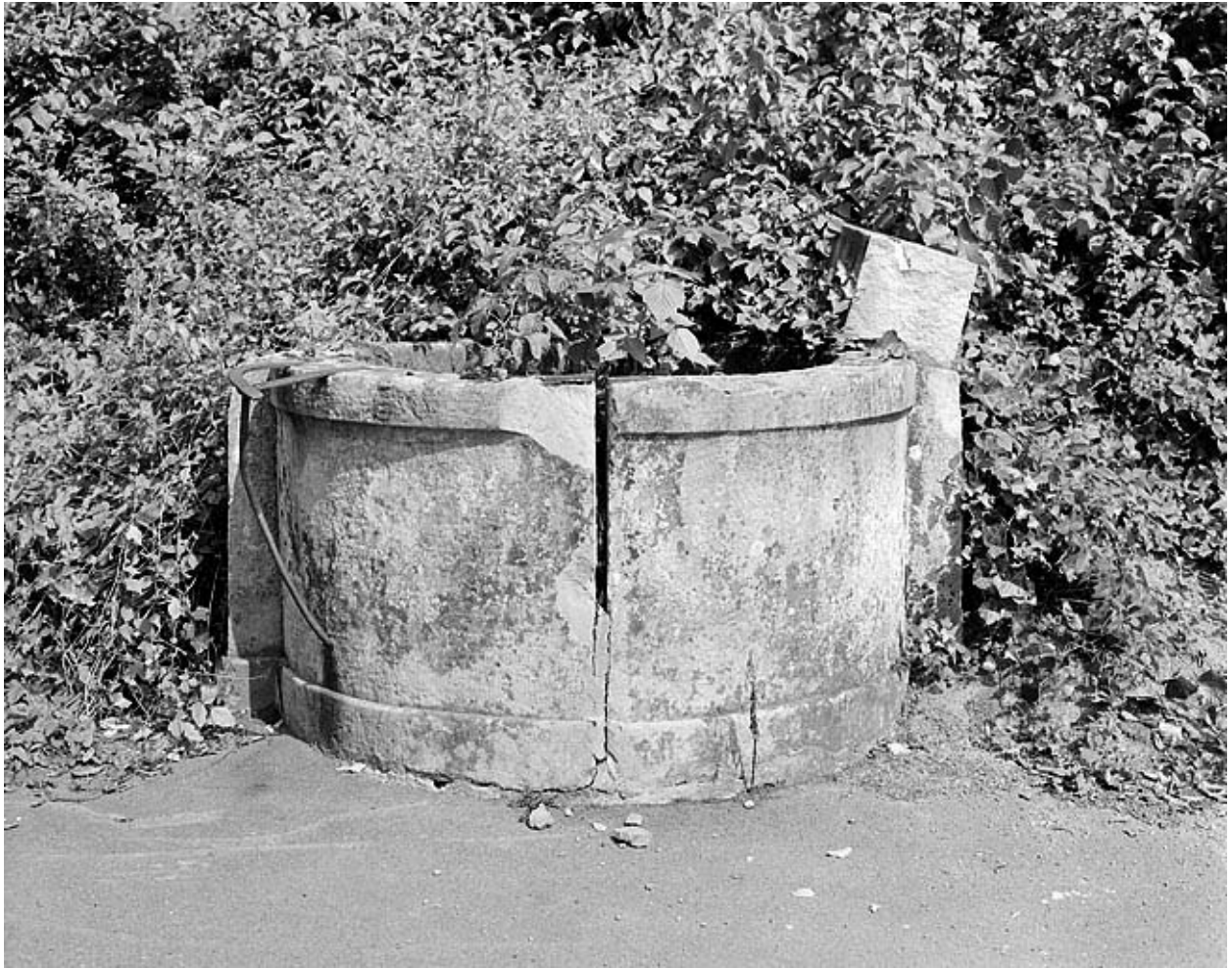
Puits. Il possédait des piédroits, aujourd'hui ruinés, supportant un linteau auquel était accroché la potence.
