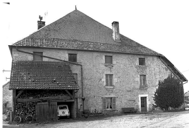
Façade postérieure. Phot. Yves Sancey IVR43_19802500871X
