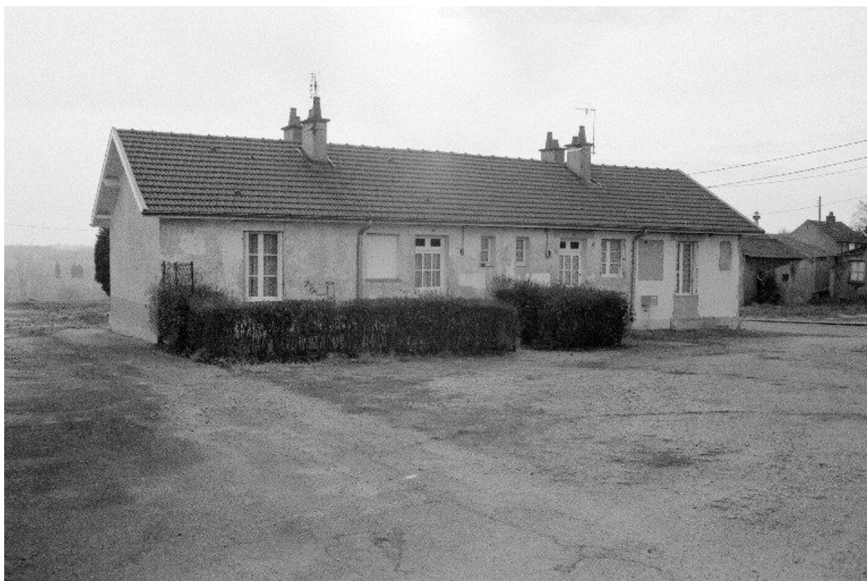
Façade antérieure d'un bâtiment à 3 logements, " type R ", au 1 rue Frédéric Chopin.
