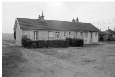
Façade antérieure d'un bâtiment à 3 logements, " type R ", au 1 rue Frédéric Chopin. Phot. Frédéric Pillet IVR26_19997100091Z
