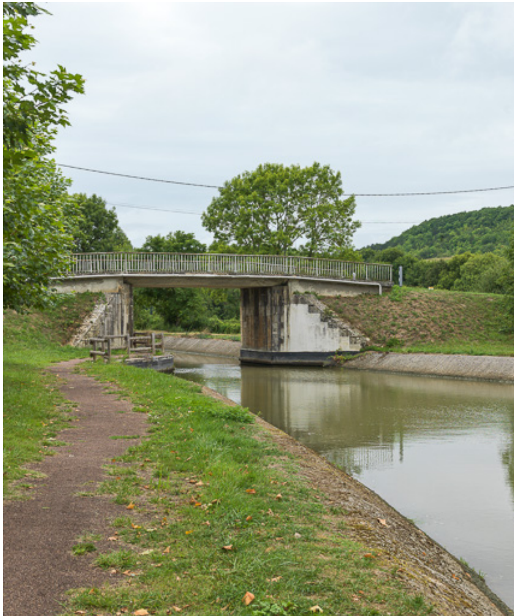
Vue d'ensemble du pont.
