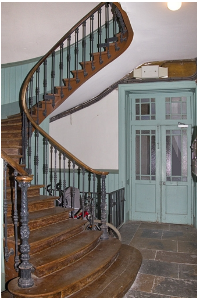
Intérieur : vue d'ensemble de l'escalier.
