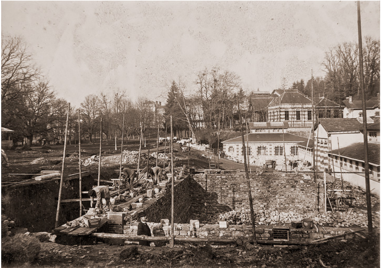
Construction du pavillon de la piscine.
