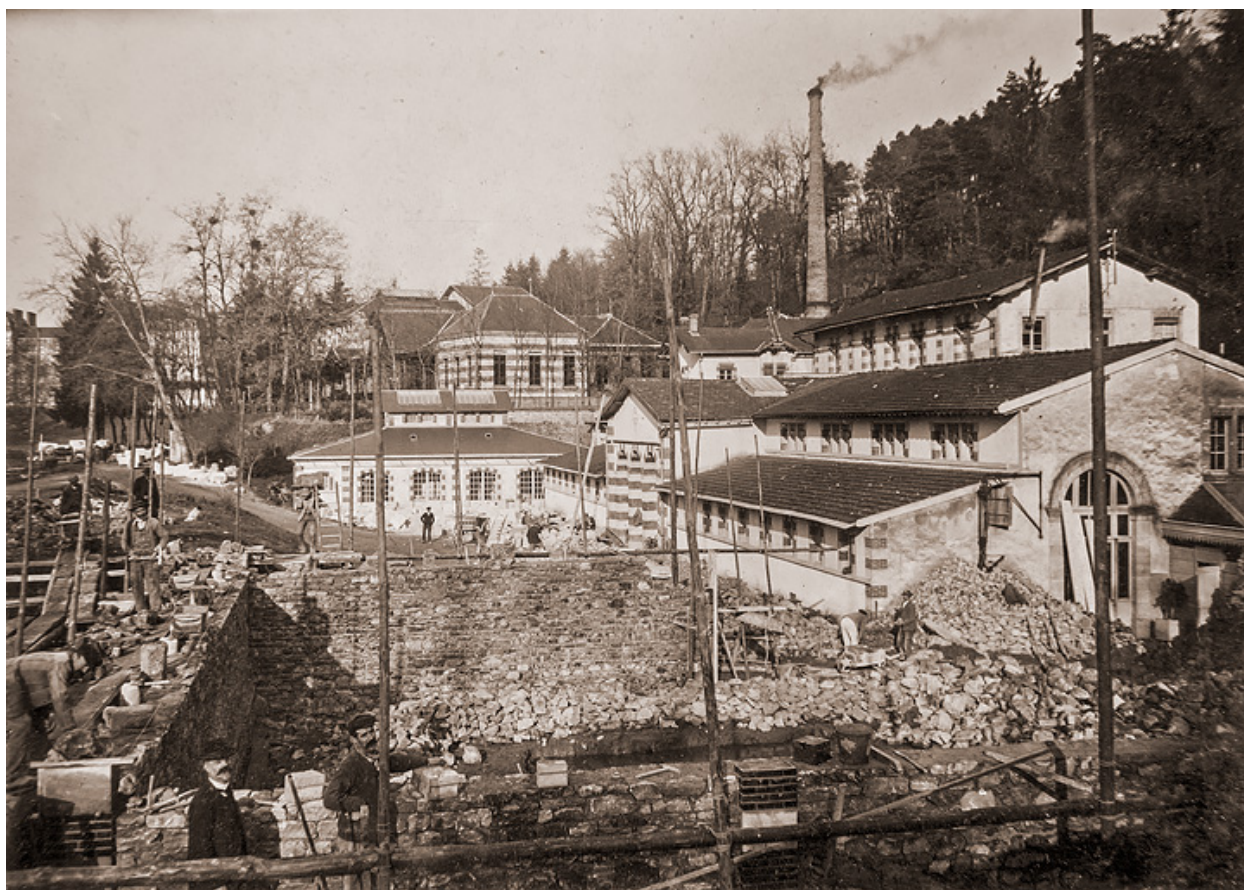
Construction du pavillon de la piscine.
