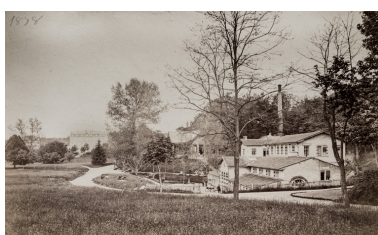
Façade principale, état en 1878. Phot. Pierre-Marie Barbe- Richaud, Autr. auteur inconnu IVR26_20195800299NUC4A
