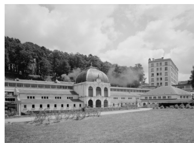
Vue d'ensemble depuis le nord-ouest à la fin des années 1970. Phot. Jean-Luc Duthu IVR26_19775800595V
