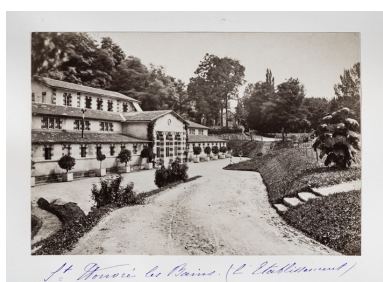
Façade principale, état en 1878. Phot. Pierre-Marie Barbe- Richaud, Autr. auteur inconnu IVR26_20195800296NUC4A
