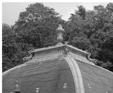
Pavillon central, détail de la couverture. Phot. Michel Thierry IVR26_19775800600X
