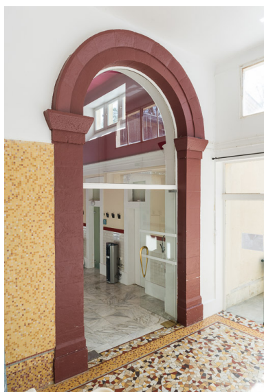
Extrémité de l'aile nord, entrée de la galerie. Phot. Pierre-Marie Barbe-Richaud IVR26_20195800200NUC4A
