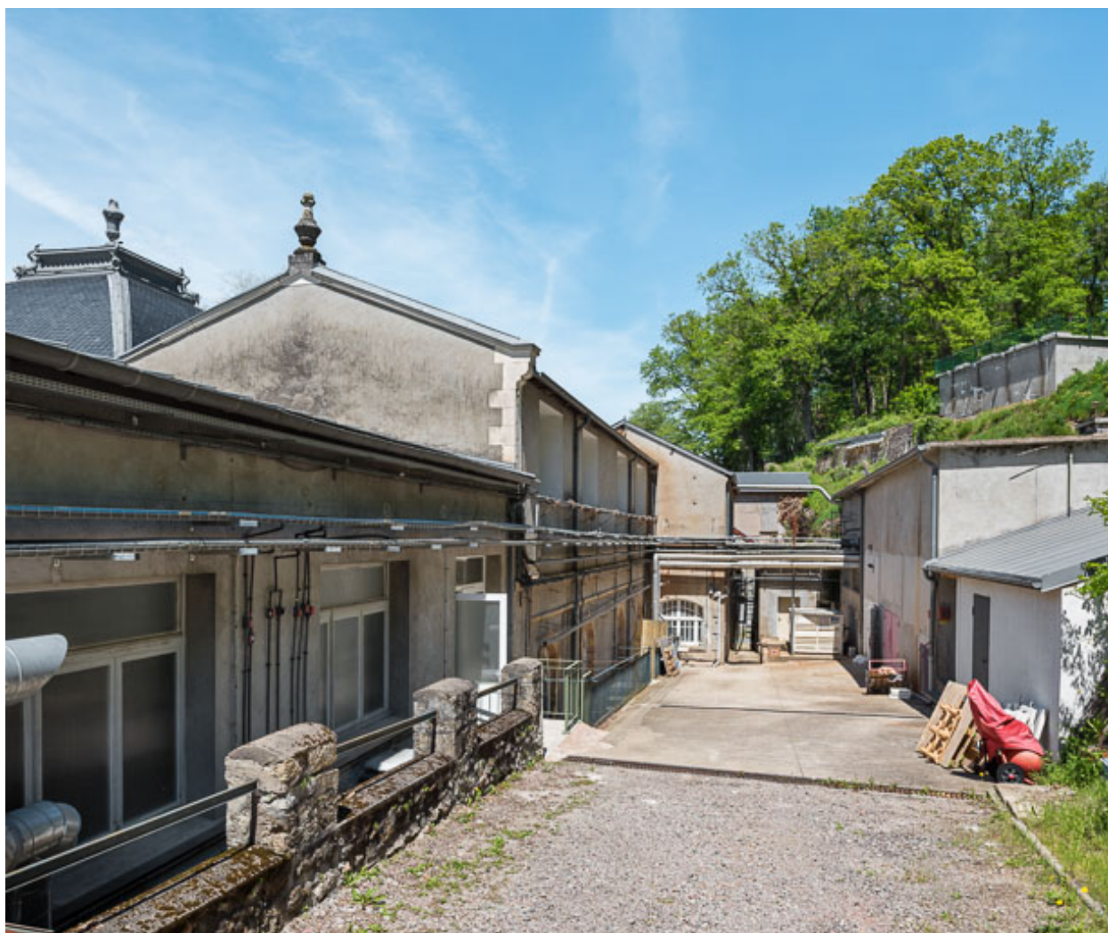
Façade sur l'arrière-cour, vue en direction du nord.
