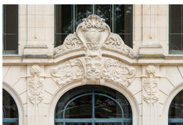
Pavillon central, décor sculpté au-dessus de la baie centrale. Phot. Pierre-Marie Barbe-Richaud IVR26_20195800406NUC4A
