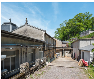
Façade sur l'arrière-cour, vue en direction du nord. Phot. Pierre-Marie Barbe-Richaud IVR26_20195800185NUC4AQ
