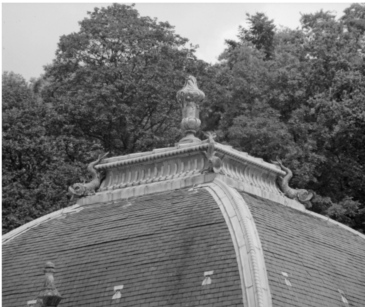
Pavillon central, détail de la couverture.
