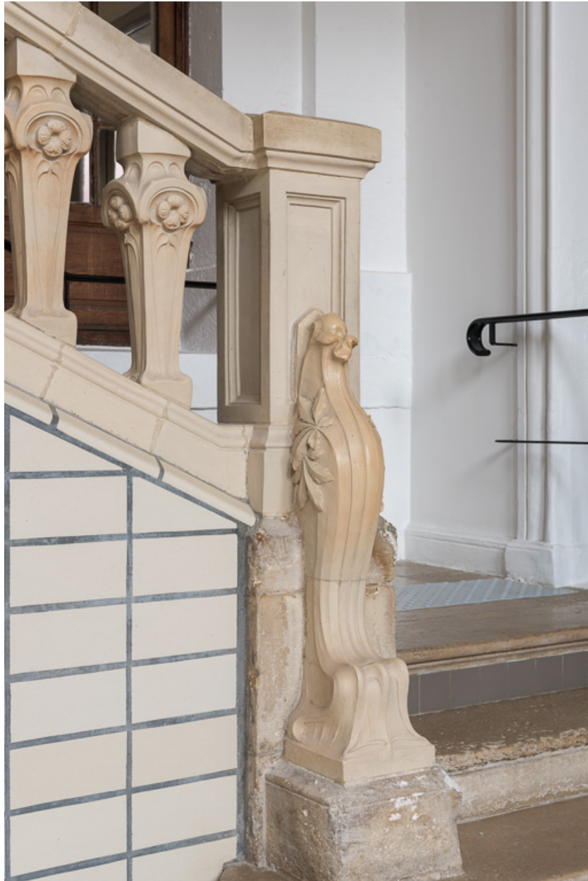
Hall des sources, rampe du degré, détail.
