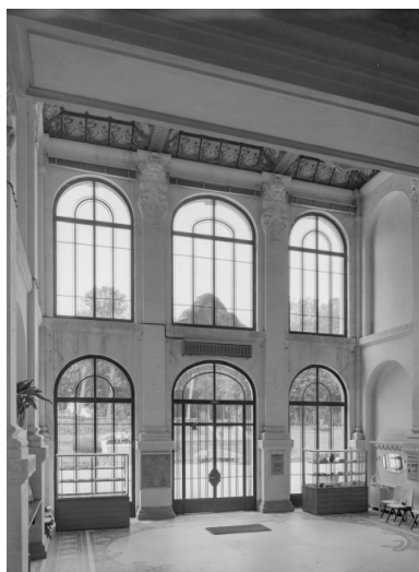
Hall des sources, mur antérieur. Phot. Jean-Luc Duthu IVR26_19845800076V
