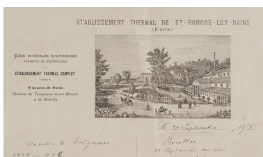
Façade principale, état dans les années 1870. Phot. Pierre-Marie Barbe- Richaud, Autr. auteur inconnu IVR26_20195800454NUC2A
