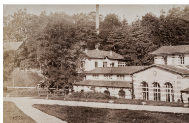
Façade principale, état en 1883. Phot. Pierre-Marie Barbe-Richaud, Autr. auteur inconnu IVR26_20195800304NUC4A
