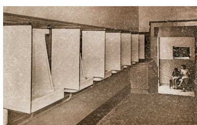
Salle de gargarisme à l'emplacement de la salle d'inhalation de première classe. Autr. auteur inconnu IVR26_20195800139NUC2A
