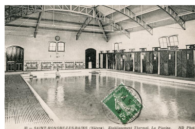
Vue intérieure de la troisième piscine. Autr. auteur inconnu IVR26_20195800131NUC2A
