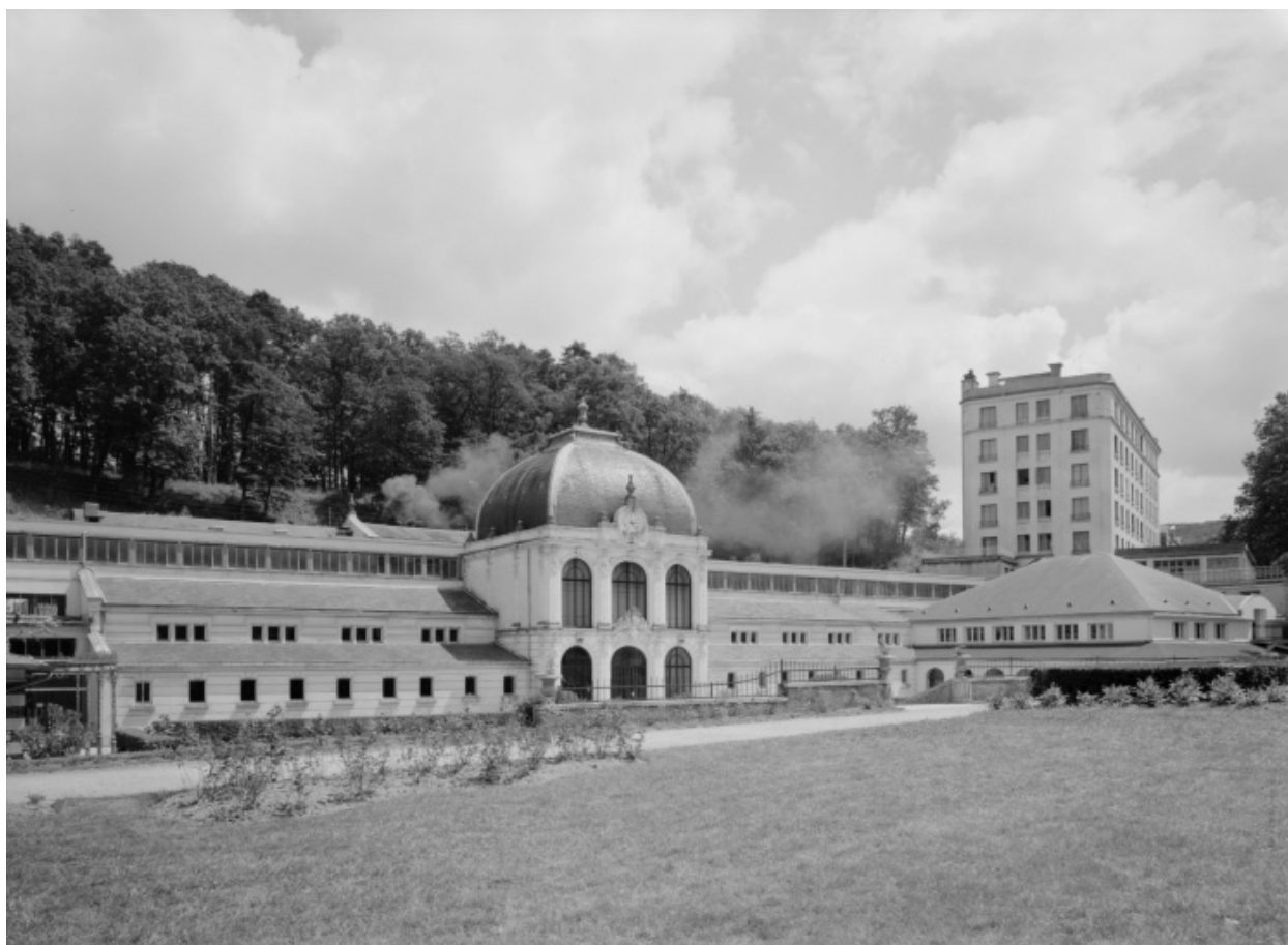
Vue d'ensemble depuis le nord-ouest à la fin des années 1970.
