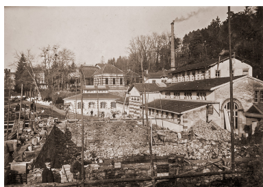
Construction du pavillon de la piscine. Phot. Pierre-Marie Barbe-Richaud, Autr. auteur inconnu IVR26_20195800450NUC4A
