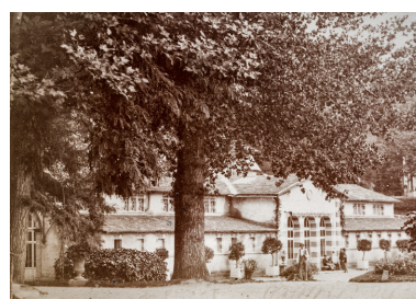
Façade principale, état en 1881. Phot. Pierre-Marie Barbe- Richaud, Autr. auteur inconnu IVR26_20195800303NUC4A
