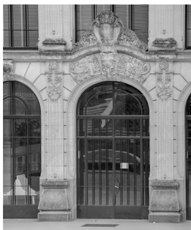
Pavillon central, entrée. Phot. Jean-Luc Duthu IVR26_19775800598XP
