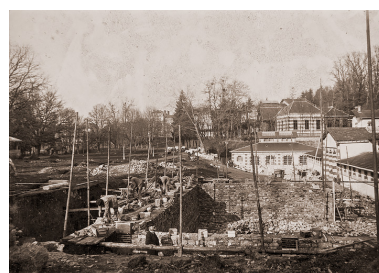
Construction du pavillon de la piscine. Phot. Pierre-Marie Barbe-Richaud, Autr. auteur inconnu IVR26_20195800449NUC4A
