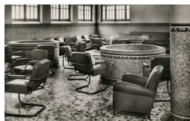
Salle d'inhalation à l'emplacement de la deuxième piscine. Autr. auteur inconnu IVR26_20195800135NUC2A
