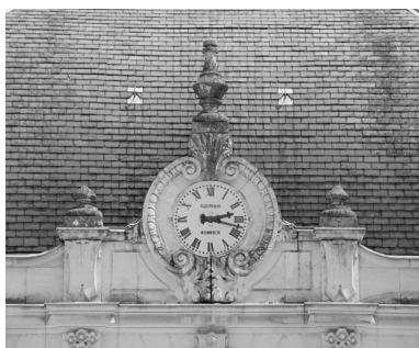
Pavillon central, détail de l'horloge. Phot. Michel Thierry IVR26_19775800599X
