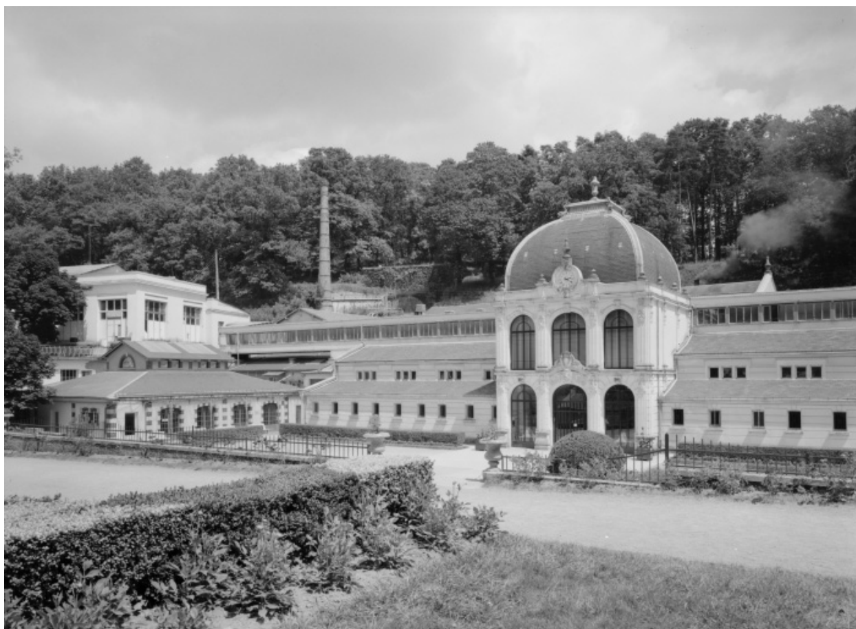
Vue d'ensemble depuis le sud-ouest à la fin des années 1970.
