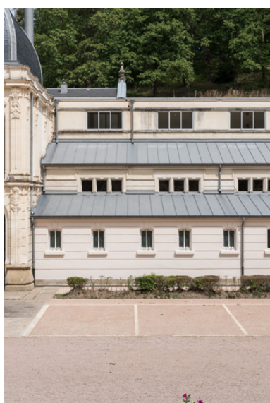
Aile sud, élévation ouest. Phot. Pierre-Marie Barbe-Richaud IVR26_20195800402NUC4A
