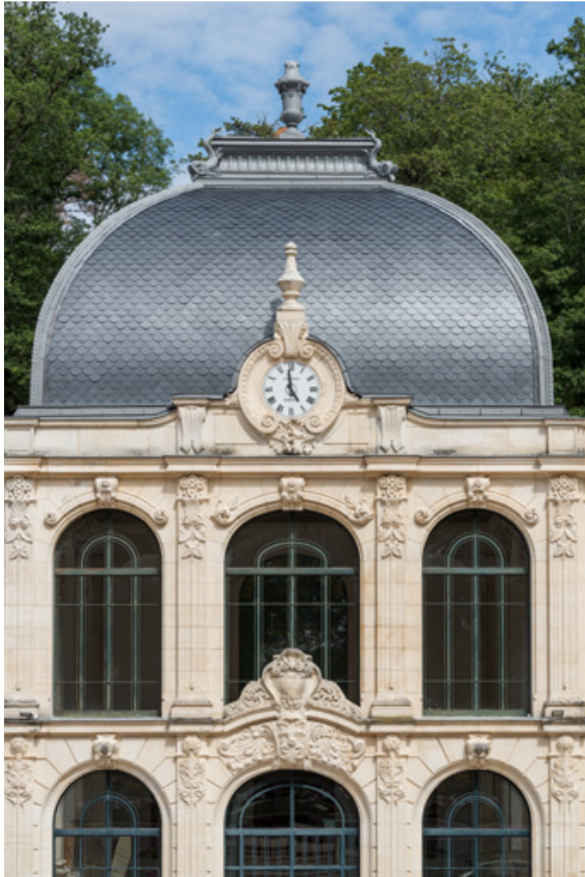
Pavillon central, vue de face, détail.
