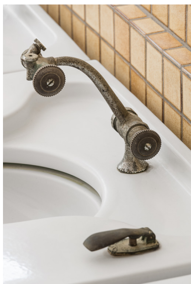
Salle de pulvérisation des enfants, robinet. Phot. Pierre-Marie Barbe-Richaud IVR26_20195800180NUC4A
