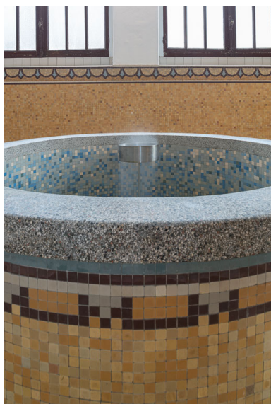
Salle d'inhalation à l'emplacement de la deuxième piscine, détail d'un puits. Phot. Pierre-Marie Barbe-Richaud IVR26_20195800082NUC4A
