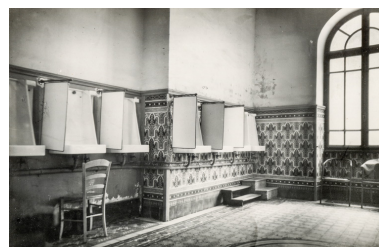
Salle de gargarisme à l'emplacement de la salle d'inhalation de première classe. Autr. auteur inconnu IVR26_20195800273NUC4A
